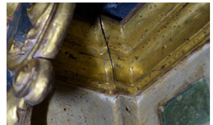
Figura 19. Separación de la estructura
