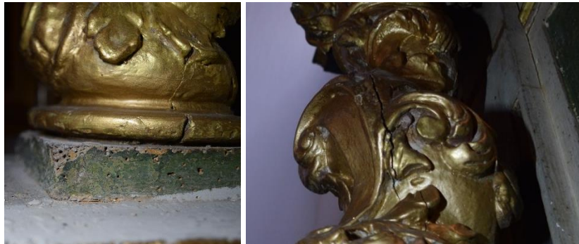
Figuras 22-23. Grietas presentes en las columnas
