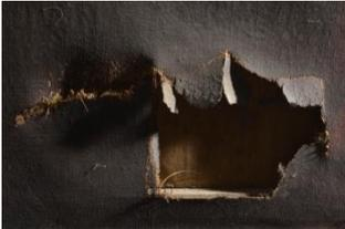
Figura 21. Detalle del faltante con luz rasante.
