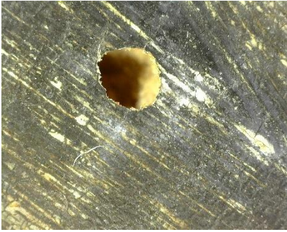
Figura 43- Detalle orificio agente xilófago
