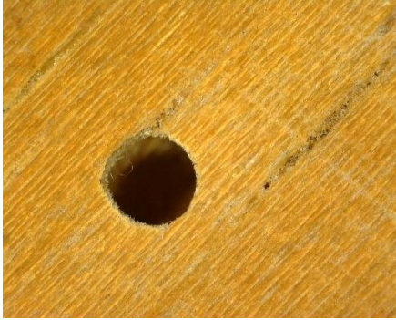
Figura 33- Detalle orificio creado por los insectos xilófagos.
