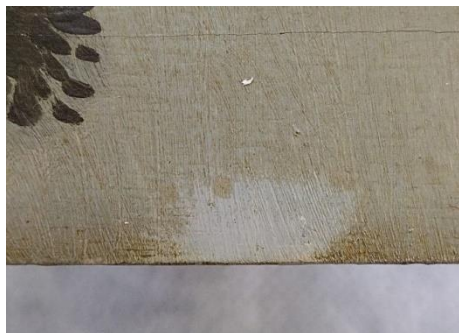
Figura 48- Detalle cata de limpieza con LE9.
