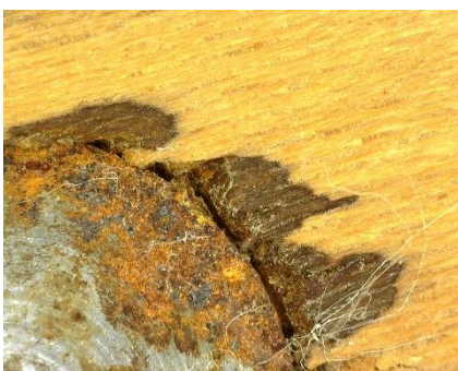
Figura 38- Detalle oxidación del tornillo.
