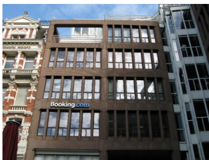
Ilustración 1 Edificio de la sede central de Booking.com en Ámsterdam (Países Bajos). Fuente: booking.com - Wikipedia, la enciclopedia libre
