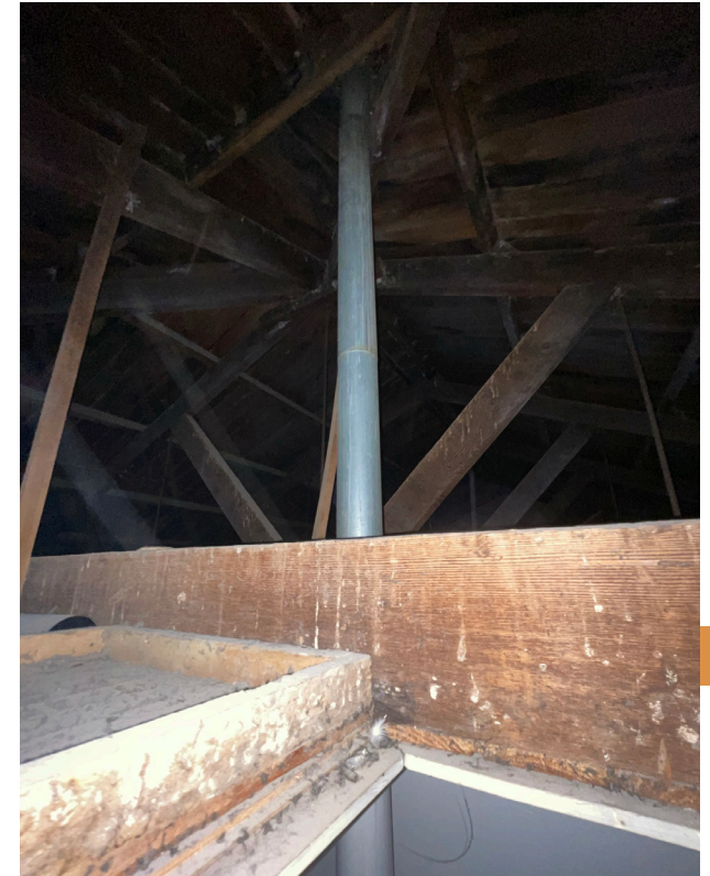
Imagen 122: Estructura de Cubierta Fuente : Elaboración Propia
