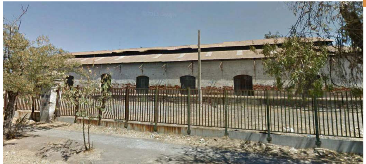
Imagen 80: Bodega Demolida en el Marco de los Trabajos de Construcción de la Nueva Estación Soterrada Fuente : Archivo Empresa de Ferrocarriles del Estado
