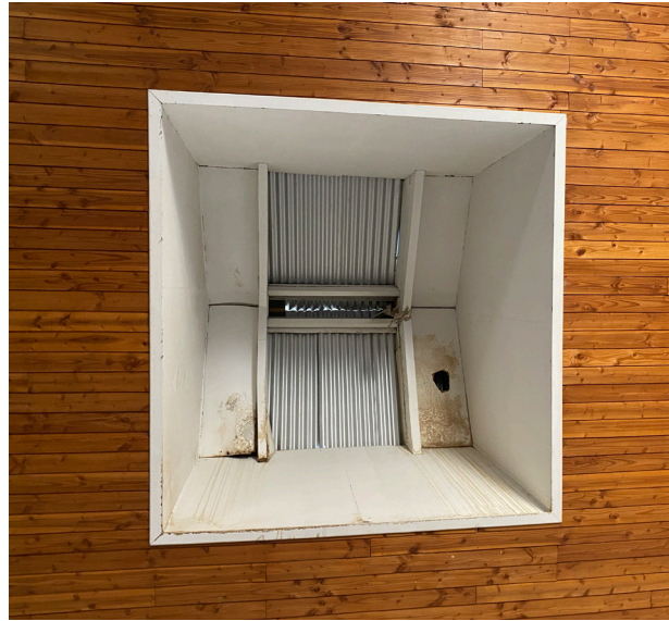
Imagen 134: Listoneado De Cielo Interior Fuente : Elaboración Propia
