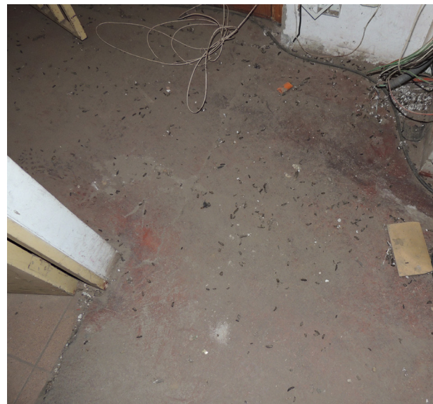
Imagen 147: Pavimento Interior Fuente : Elaboración Propia
