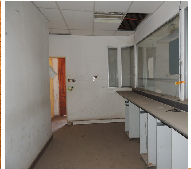
Imagen 135: Listoneado de Cielo Exterior Fuente : Elaboración Propia
