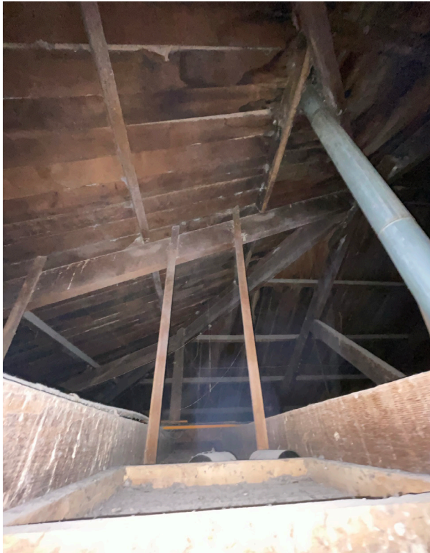
Imagen 120: Estructura de Cubierta Fuente : Elaboración Propia
