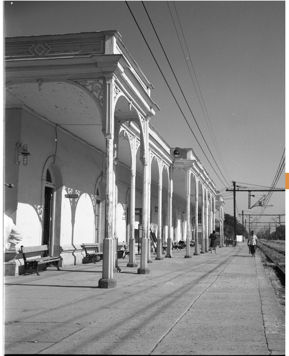
Imagen 75: Estación de FF.CC de San Bernardo Fuente : Archivo Fotográfico del Ministerio de Obras Públicas Chile
