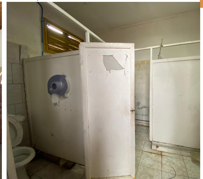
Imagen 126: Pavimento Interior Estación Recinto Baño Fuente : Elaboración Propia
