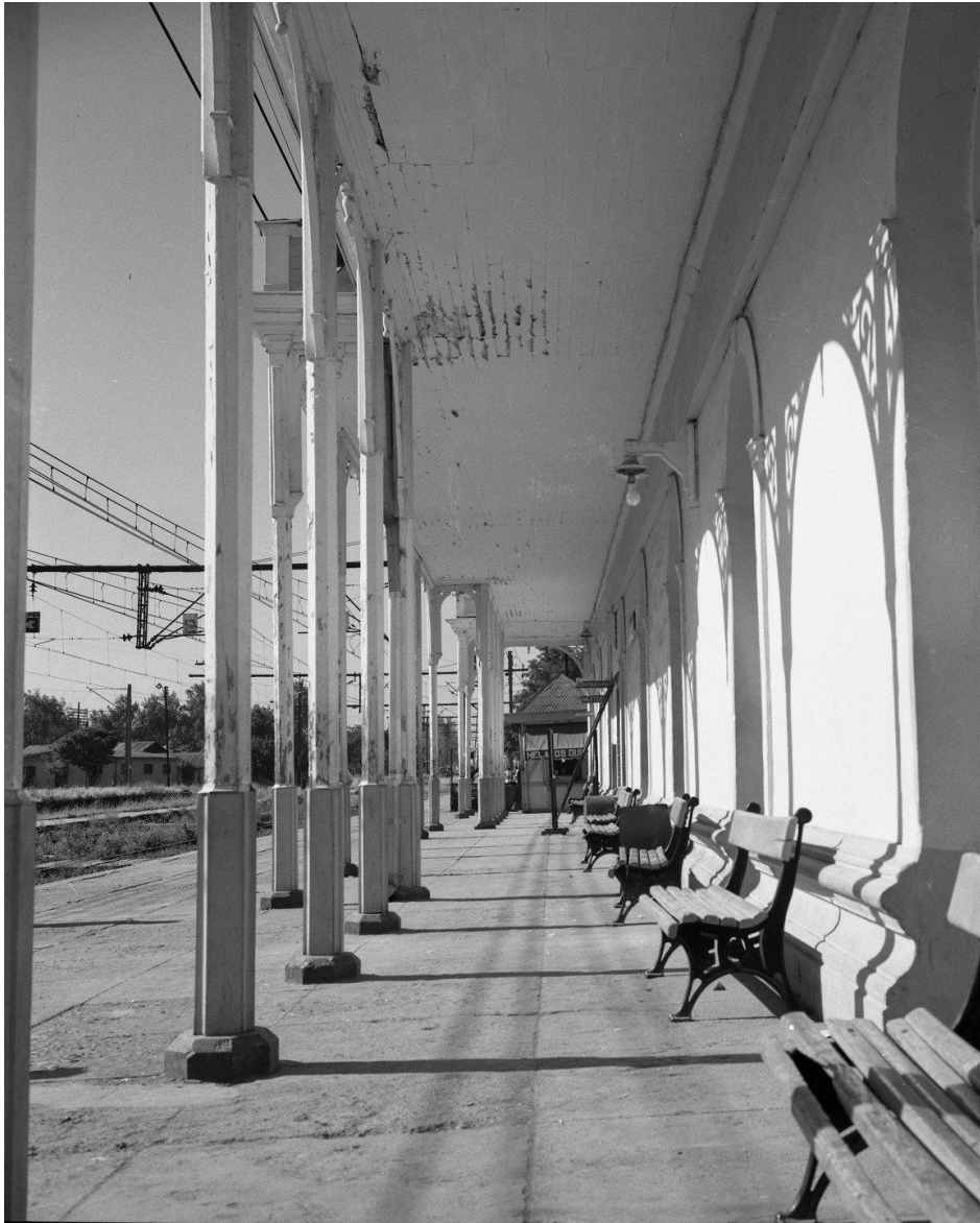
Imagen 74: Estación de FF.CC de San Bernardo Fuente : Archivo Fotográfico del Ministerio de Obras Públicas Chile
