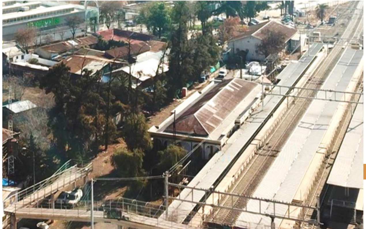
Imagen 81: Imagen de Intervención en Estación de Ferrocarriles de San Bernardo Año 2014 Fuente : Archivo Empresa de Ferrocarriles del Estado
