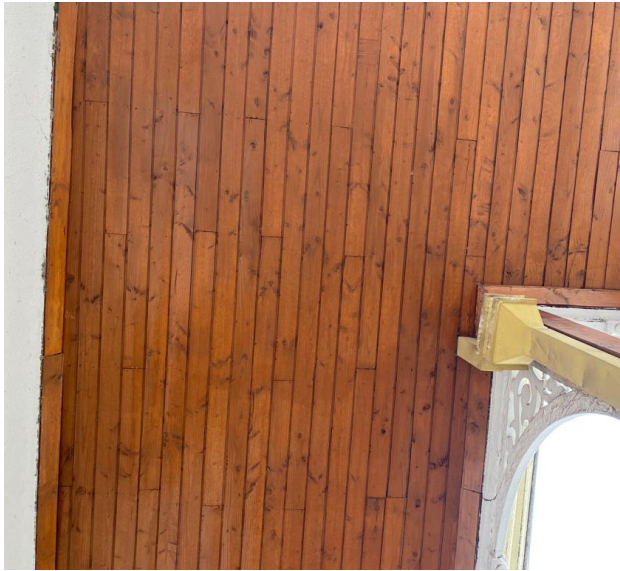
Imagen 133: Listoneado de Cielo Exterior Fuente : Elaboración Propia
