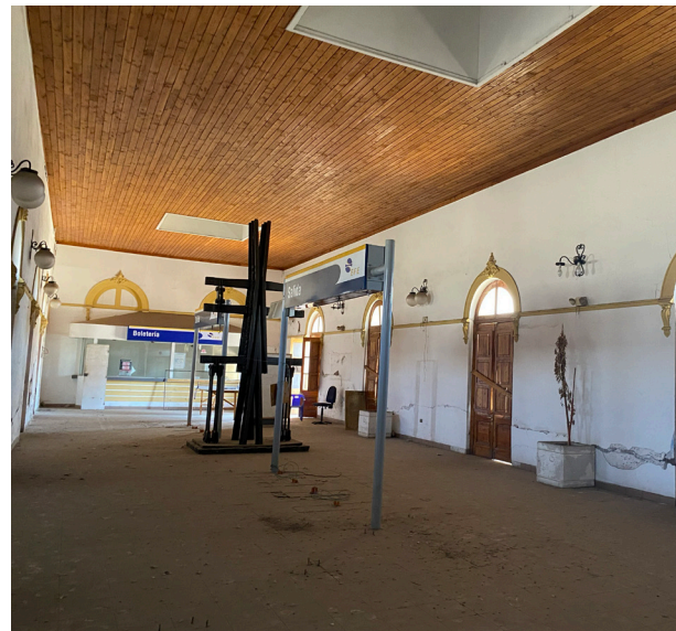
Imagen 125: Pavimento Interior Estación Fuente : Elaboración Propia
