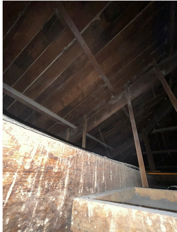
Imagen 121: Estructura de Cubierta Fuente : Elaboración Propia
