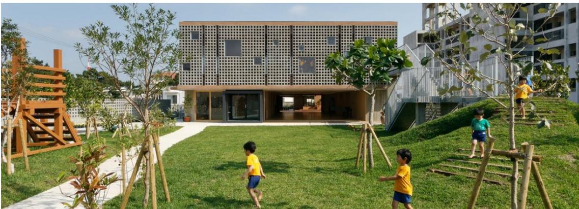
**Figura 1.02.** Fotografía Guardería de Hanazono, La fachada revestida por celosías de hormigón permiten la entrada de constante del aire. Hyakojima, Japón. Hibinosekkei + Youji No Shiro. 2015. Fotografía: Studio Bauhaus
