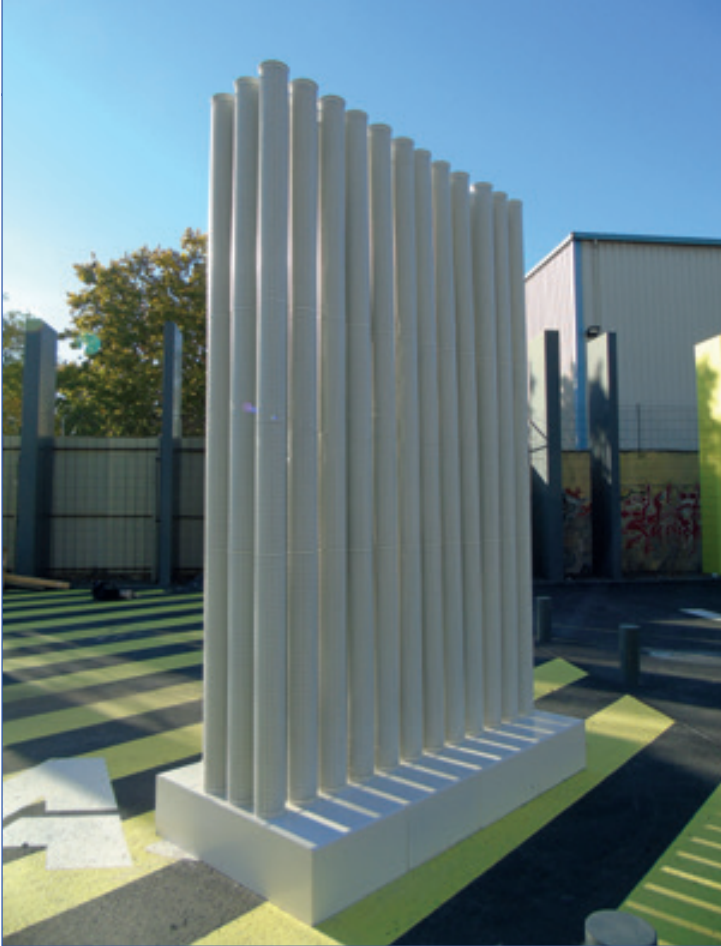
Foto 2. Imagen de pantalla acústica desarrollada por la UPV y BECSA, presentada en Innovacarretera 2017.
