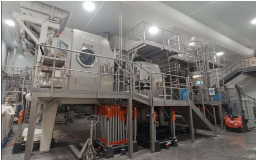
Ilustración 15. Sala de Bombos
