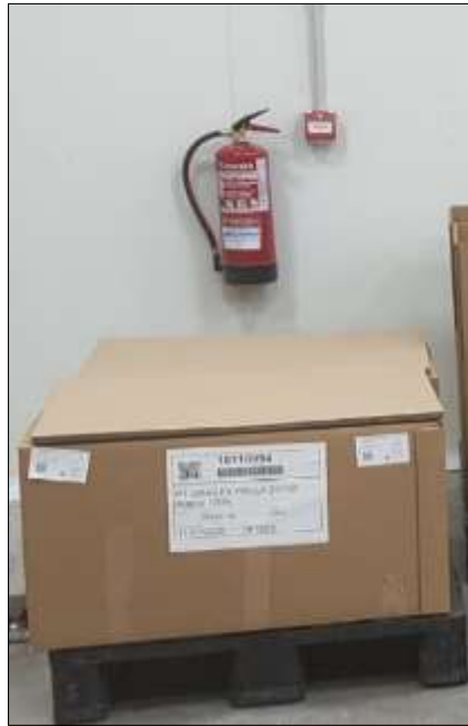
Ilustración 40. Cajas mal ubicadas
