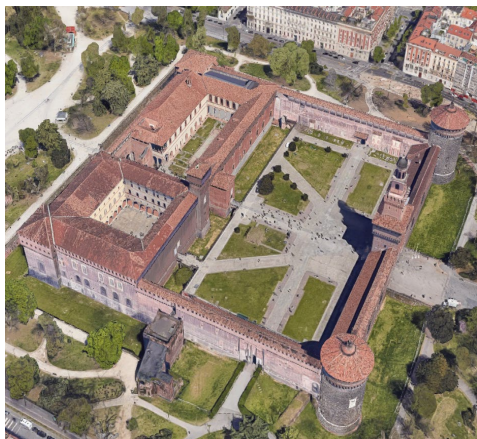
Fig. 1- Vista aerea del Castello di Milano. A sinistra, la Rocchetta e il suo cortile (Google Italia 2023)
