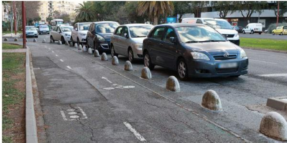
Figura 17. Separadores puntuales h > 15\text{cm} Fuente: (Ministerio de Transportes, Movilidad y Agenda Urbana, 2023)
