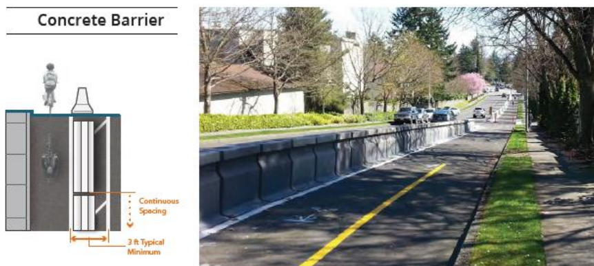
Figura 9. Barreras en concreto
