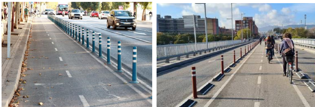
Figura 18. Hitos cilíndricos / bolardos Fuente: (Ministerio de Transportes, Movilidad y Agenda Urbana, 2023)
