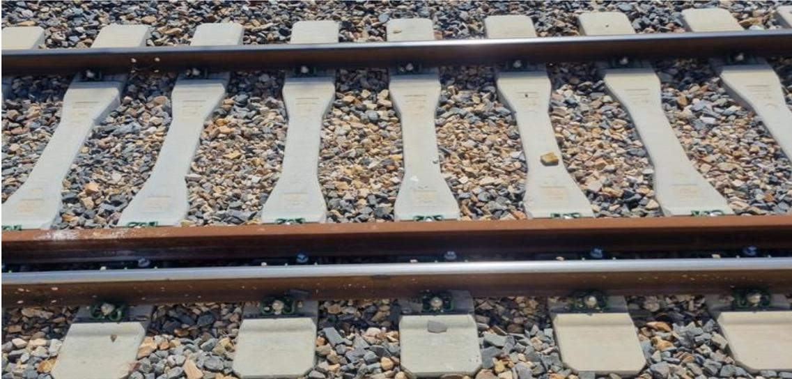
*Ilustración 24. Tramo de la vía en donde se aprecian las traviesas AM-05 y la vía de tres carriles. (Elaboración propia)*
