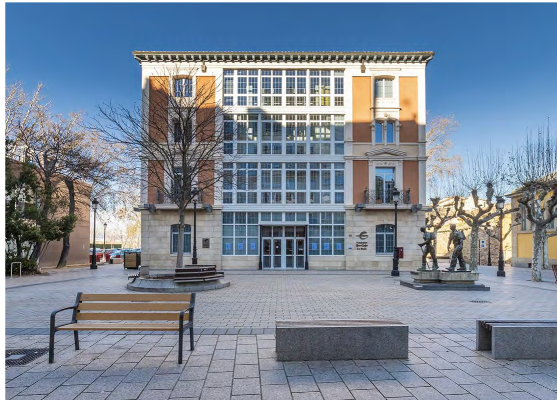
Fig. 15 Pul abans de la intervenció. (s. f.).
