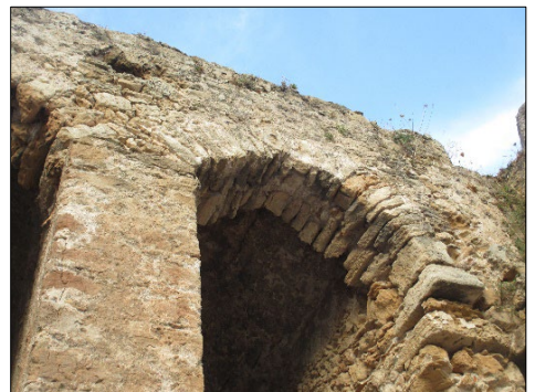
Fig. 11- Bastione della Maddalena. Dettaglio della tecnica costruttiva che prevede una connessione tra setti e archi in muratura (2016).
