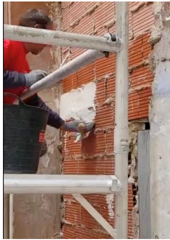
Figura 6. Aplicación del mortero de cal en el reverso de la obra. Foto de Vladimir Na
