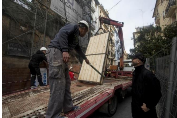
Figura 18. Levantamiento del mural al camión. Foto de Vladimir Na
