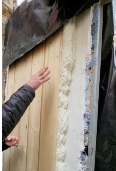
Figura 12. Fijación de protección con espuma de poliuretano. Foto de Vladimir Na
