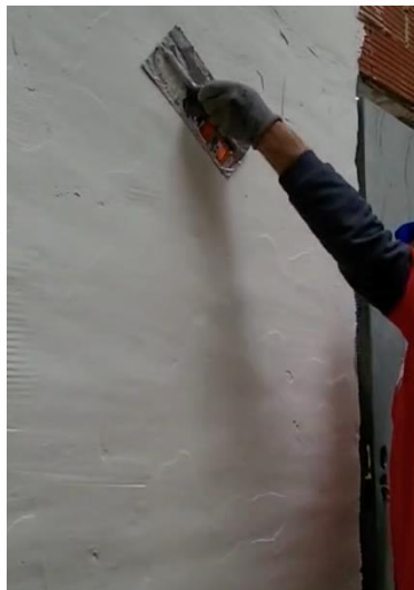
Figura 8. Nivelación del mortero. Foto de Vladimir Na
