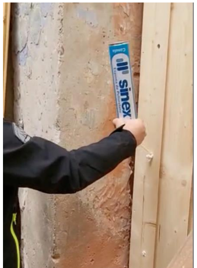
Figura 14. Perforación y relleno de protección del anverso. Foto de Vladimir Na
