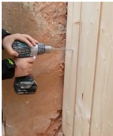
Figura 13. Perforación y relleno de protección del anverso. Foto de Vladimir Na
