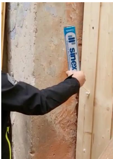
Figura 14. Perforación y relleno de protección del anverso. Foto de Vladimir Na
