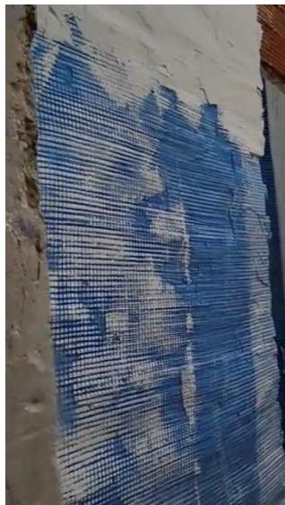
Figura 7. Aplicación de malla de plástico. Foto de Vladimir Na
