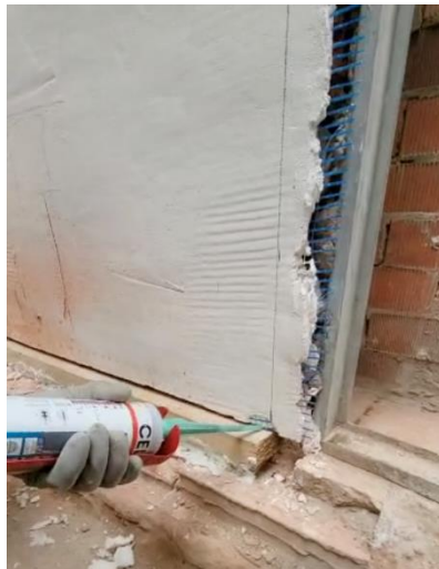
Figura 10. Aplicación de viga inferior y fijación. Foto de Vladimir Na
