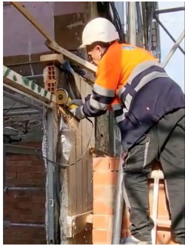
Figura 15. Corte del muro con sierra radial. Foto de Vladimir Na
