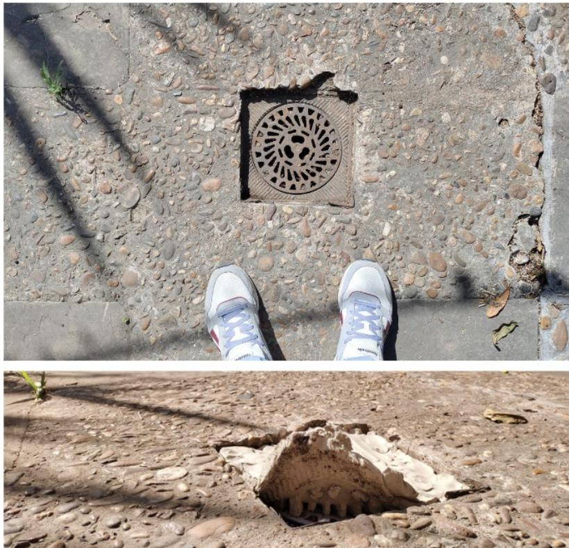
**Fig. 4.** Proceso de registro de la pieza III (Desagüe) con pasta PRAI refractaria.
