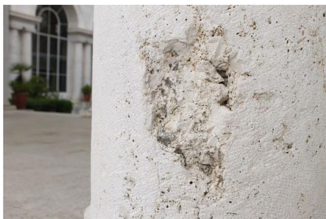
**Fig. 1** Fotografía de detalle de impacto de metralla sobre una columna del patio interior de La Casa de Velázquez de Madrid.
