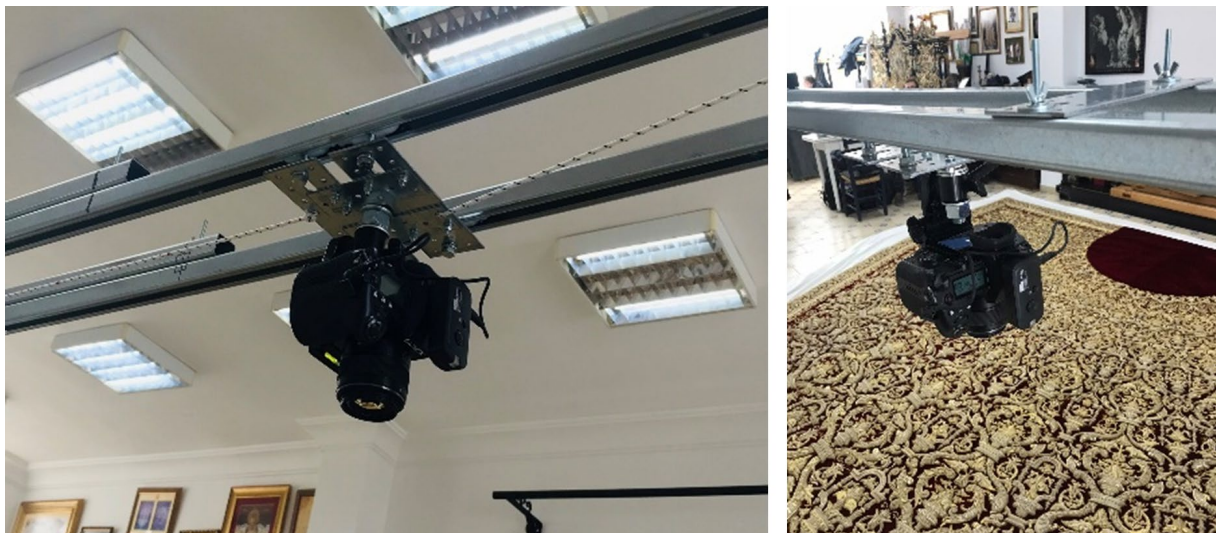
Fig. 1. Estructura auxiliar para desplazamiento de la cámara.
