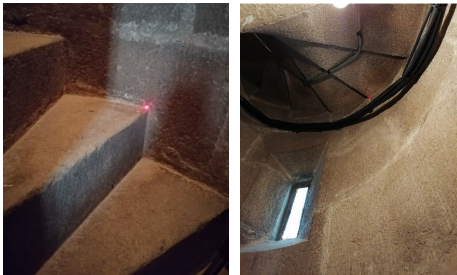
Fig. 1. Toma de datos en la parte superior e inferior de los peldaños. Fotografía de los autores
