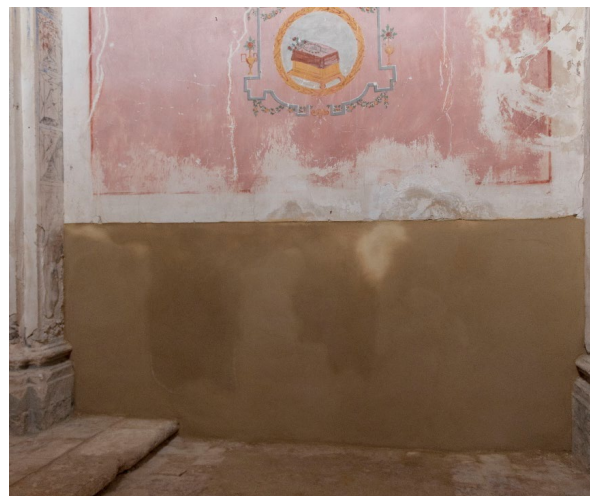
Fig. 11. Saneamiento de muro 1. Elaboración propia.
