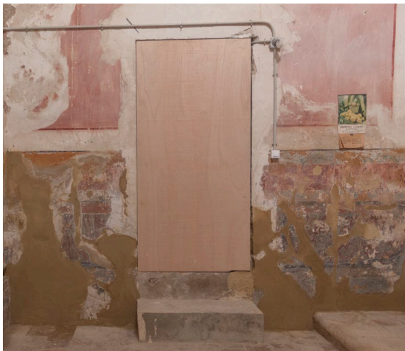
Fig. 10. Saneamiento de muro 2, dejando una ventana histórica. Elaboración propia.
