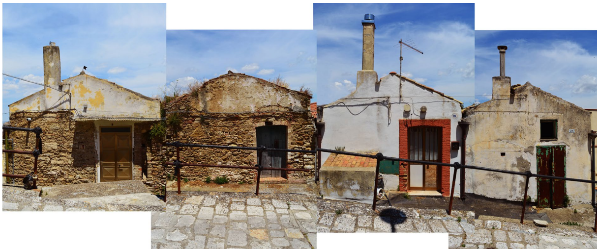
Fig. 1. Tipo de edificio antiguo de la "casa adosada" en Pomarico, Basilicata, Italia.
