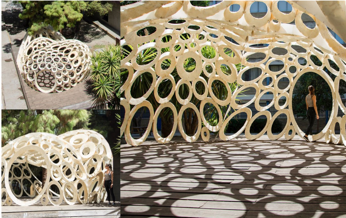
Fig. 6. Fotografías del Archimedean Pavilion después de la fabricación digital y el ensamblaje de todos los componentes.
