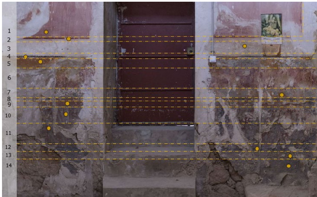
Fig. 8. Selección de las zonas de medición en el muro 2. Elaboración propia.
