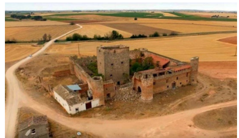
Fig. 3- Vista aérea Castillo Santiago de la Torre San Clemente, Cuenca. España. h.2016 (2)
