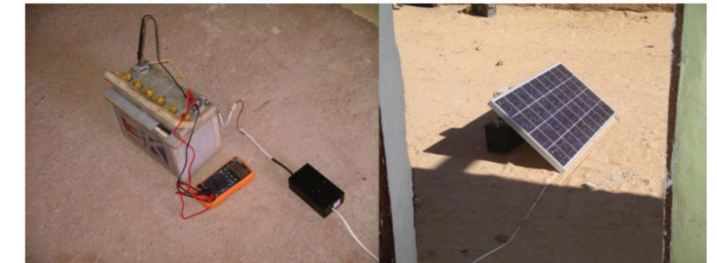
Fig 48 " Instalación de prueba del regulador de carga en el Campamentos de refugiados del sahara occidental"
