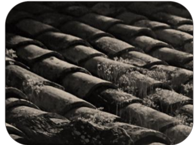
Figura 53. Cubierta de teja. Fuente: Fernando Vegas, 2011. Aprendiendo a Restaurar.
