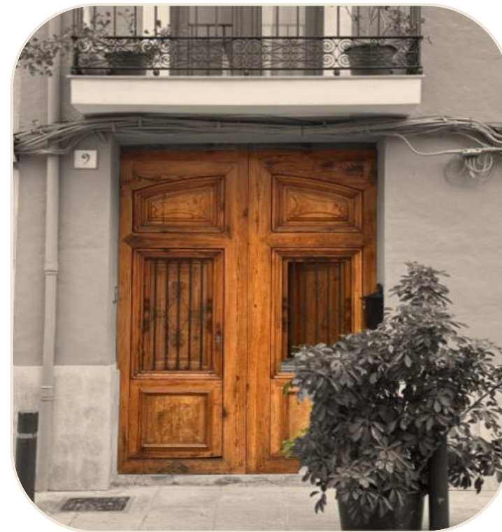
Figura 65. Puertas de apertura dobles. Fuente: Elaboración propia.
