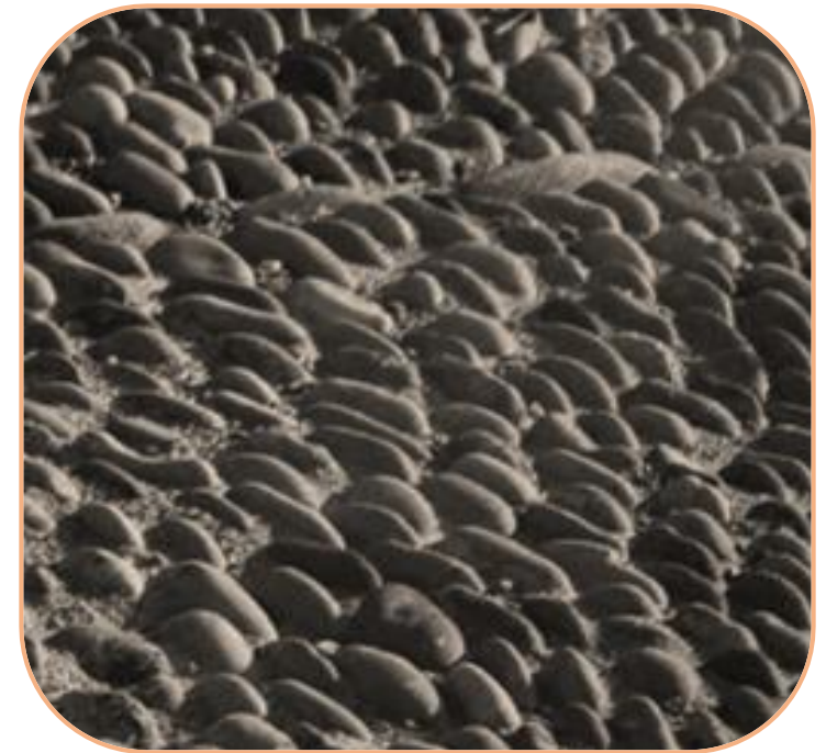
Figura 51. Pavimento en piedra. Fuente: Fernando Vegas, 2011. Aprendiendo a Restaurar.
