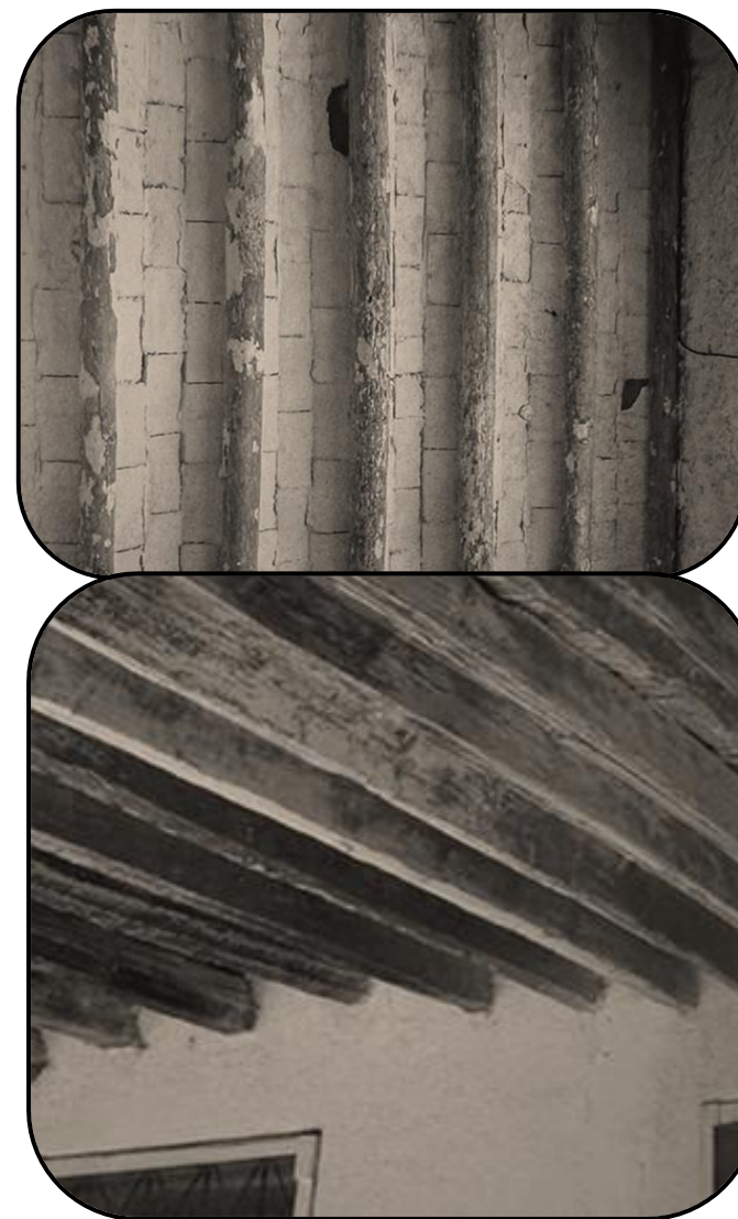
Figura 69. Viguetas tradicionales. Fuente: Elaboración propia
