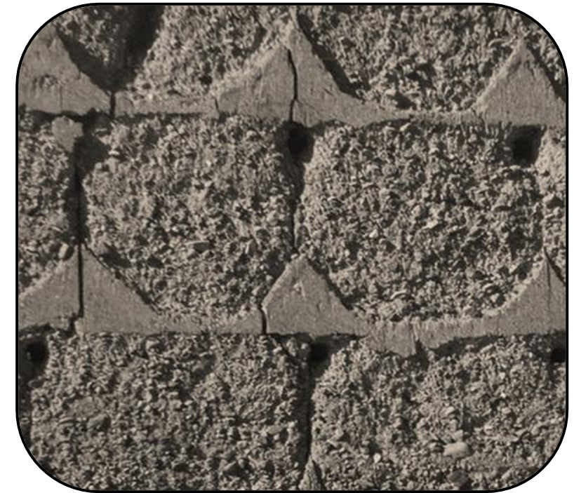
Figura 57. Muros tradicionales. Fuente: Elaboración propia.
