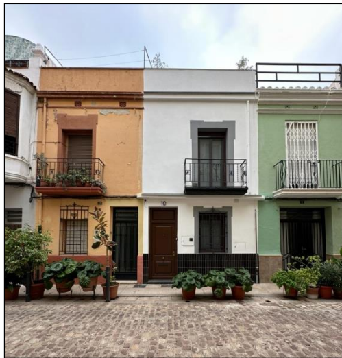
Figura 47. Tipología de vivienda tradicional del barrio ribalta. Fuente: Elaboración propia.
