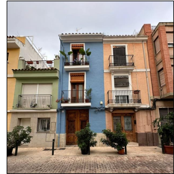
Figura 85. Viviendas residenciales distrito norte de Castellón de la Plana. Fuente: Elaboración propia
