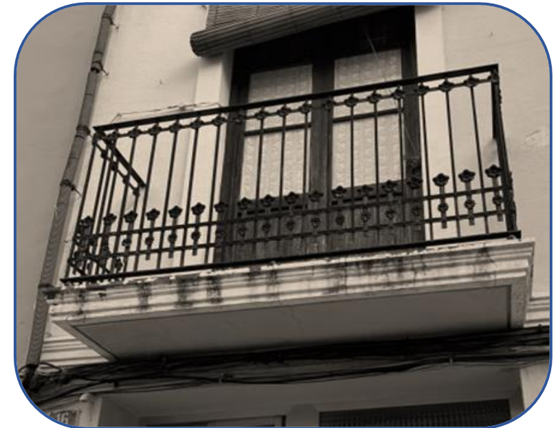
Figura 63. Balcón de fundición. Fuente: Elaboración propia.
