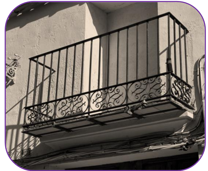
Figura 61. Balcón de forja. Fuente: Elaboración propia.
