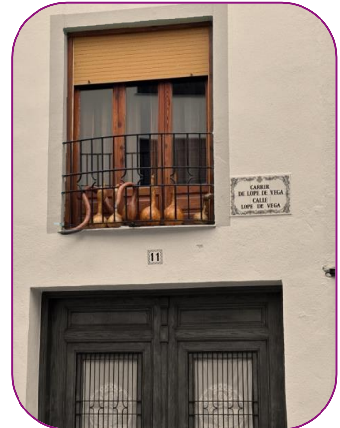
Figura 67. Rejería metálica sobresaliente. Fuente: Elaboración propia.
