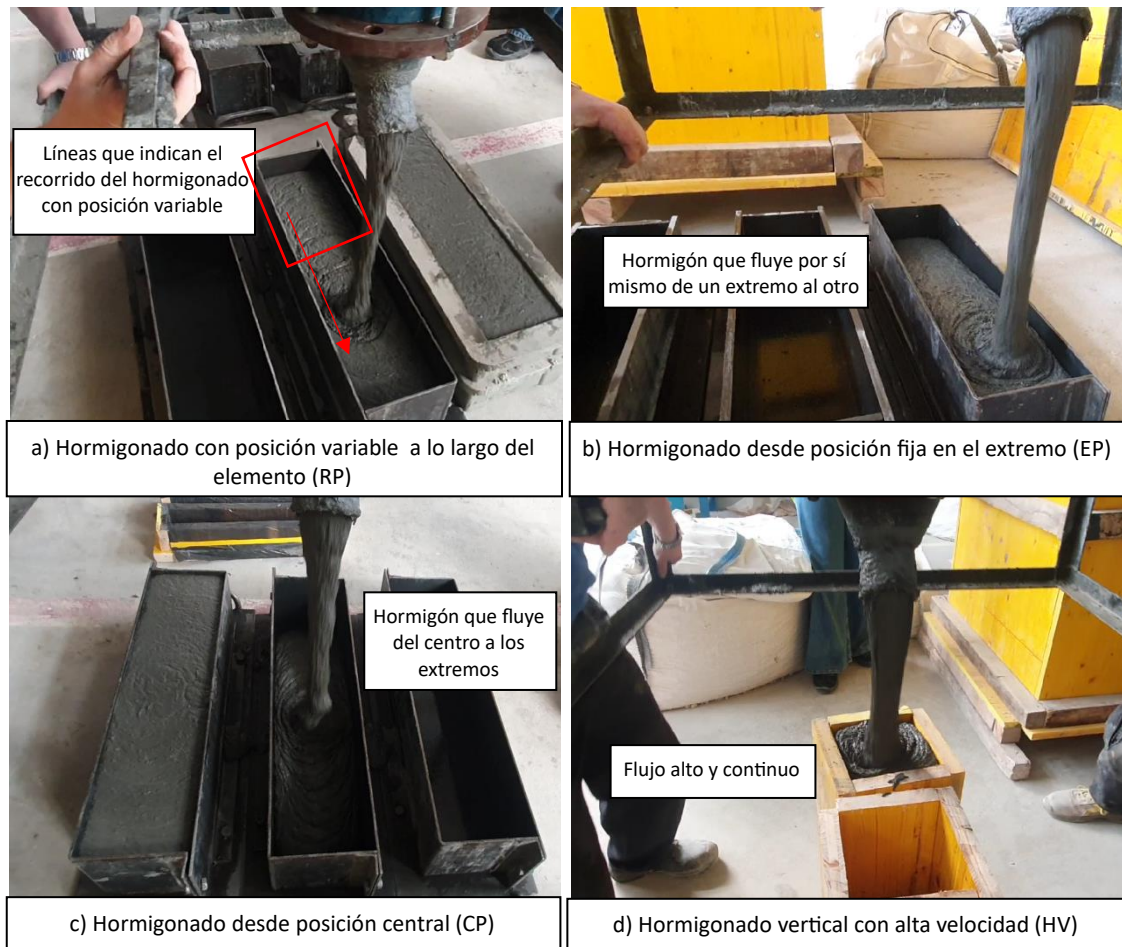
Figura 43: Secuencia de hormigonado para las vigas de 15x15x60 cm
