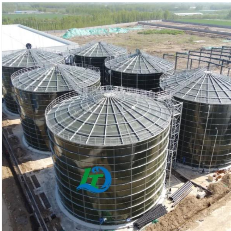
Figura 12. Digestor seleccionado para el proyecto.
