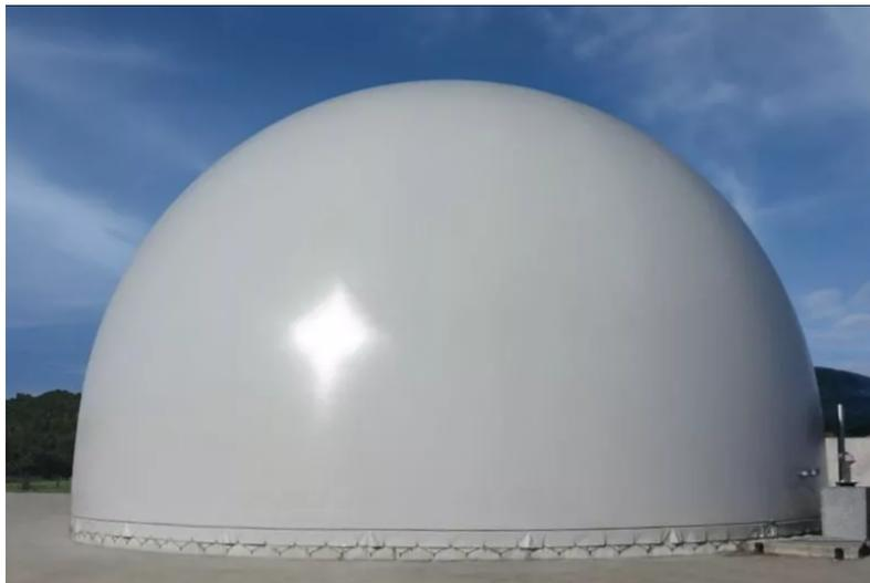
**Figura 6.5:** Gasómetro de biogás de doble membrana con forma de cúpula de  $\frac{1}{2}$  D. FUENTE: ZORG BIOGAS, s.f.
