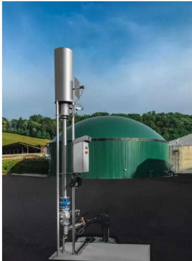
**Figura 6.7:** Antorcha FAI 32-350. FUENTE: ZORG BIOGAS, s.f.
