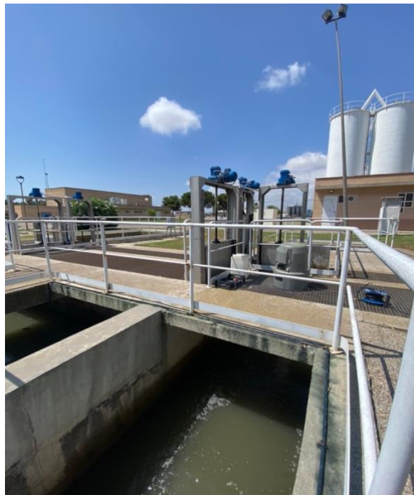
Figura 16. Tuberías de impulsión de fango. Fuente: Propia.
