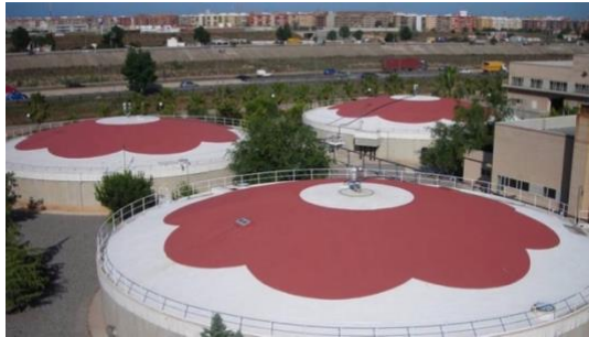
Figura 7. Digestores anaerobios. Fuente: iAguas.
