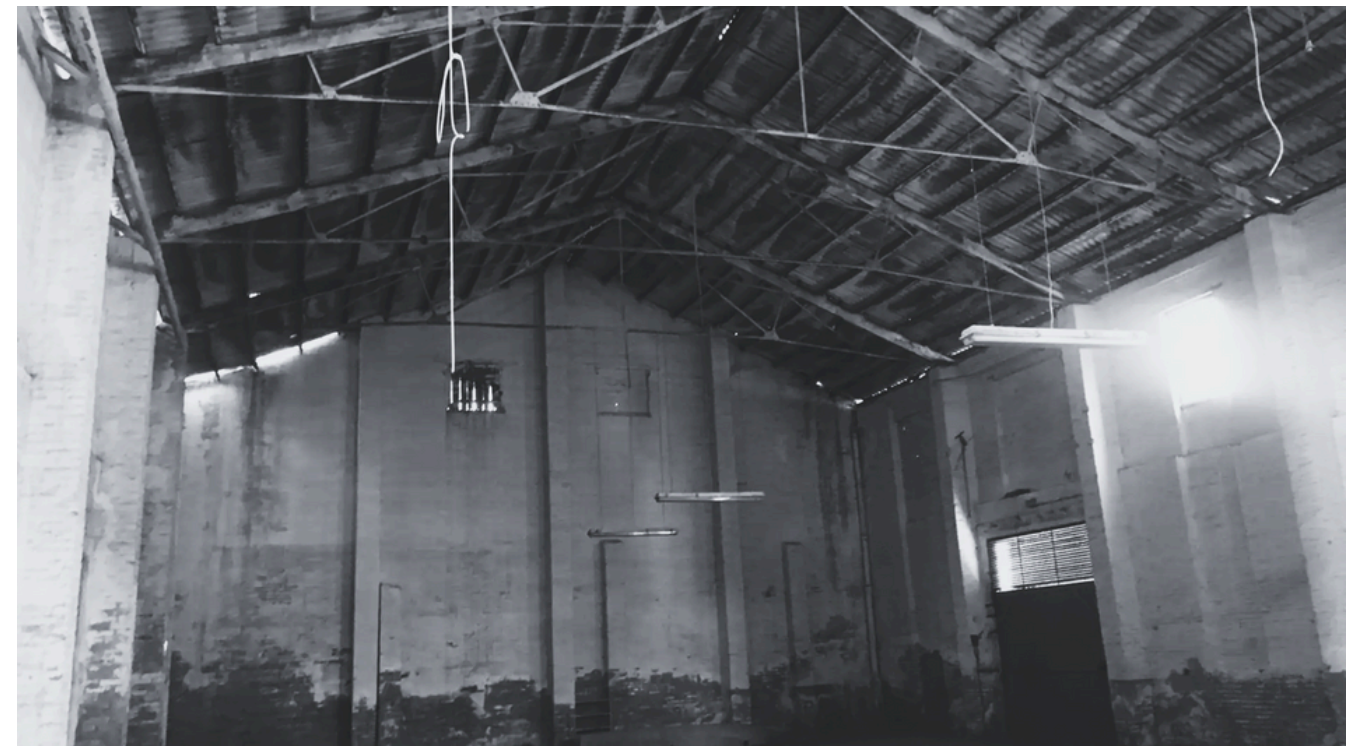
Figura 9. Interior de la nave
