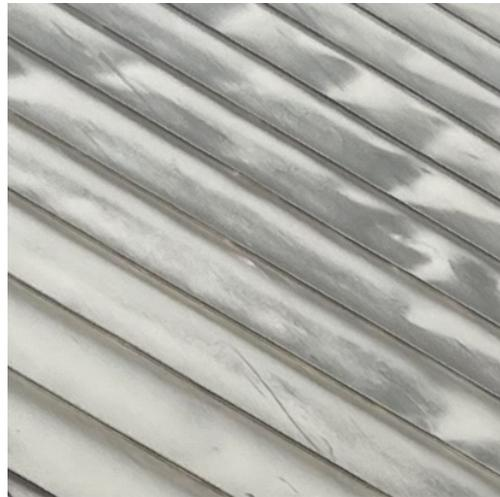
Figura 19: Paneles de zinc de la cubierta. [11]
