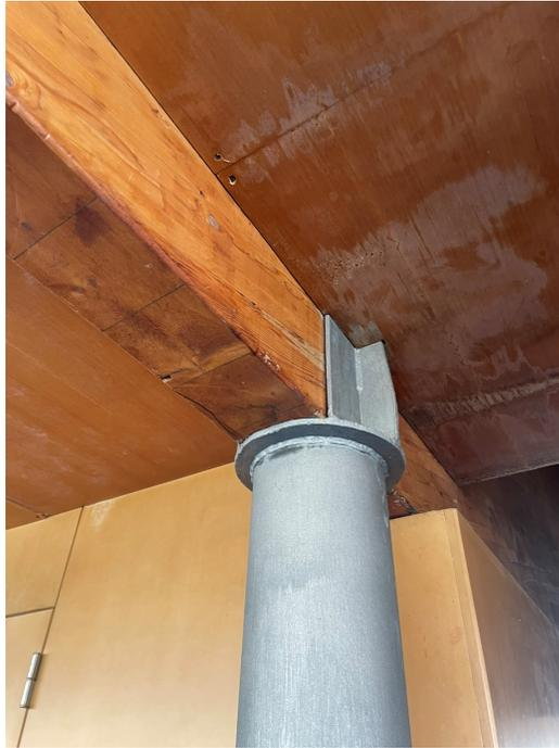
Figura 20: Detalle del encuentro entre la estructura de madera y un pilar metálico. [11]
