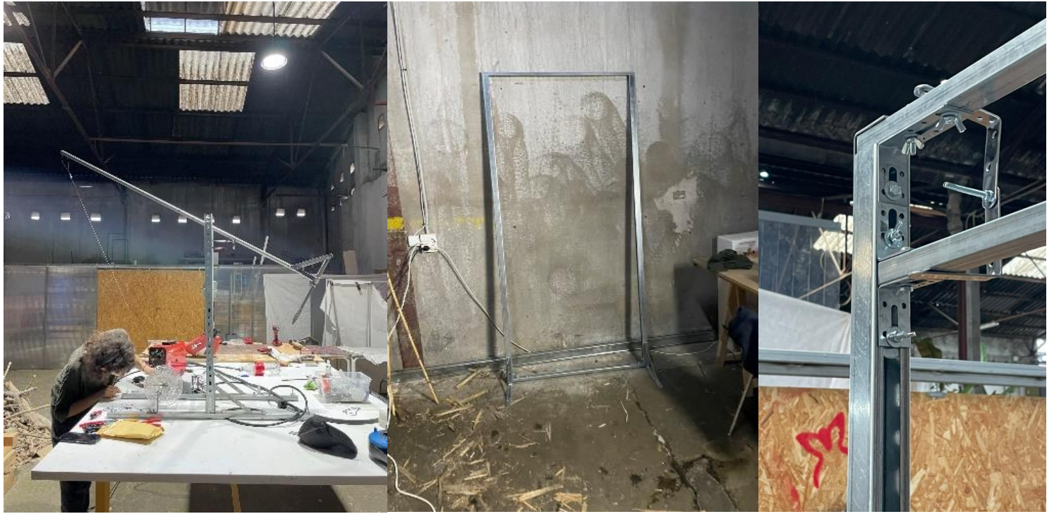
Figura 49. Fotografías del proceso de construcción de las estructuras de las máquinas.
