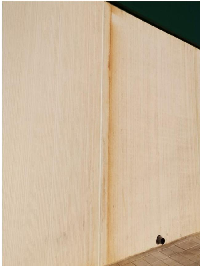
*Figura 15: Sellado con masilla entre paneles (Elaboración propia, 2024)*
