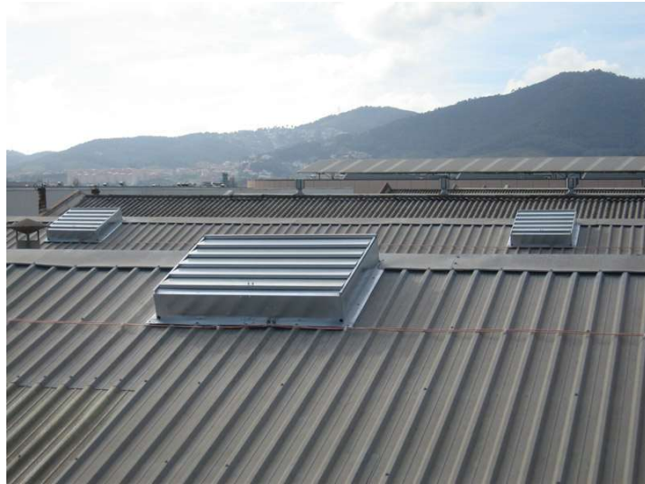
Figura 14. Ejemplo de un exutorios.
