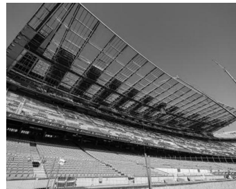
Figura 123. Desmontaje de la marquesina.
