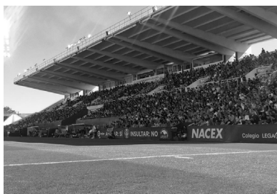
Figura 192. Estructura de la cubierta original.
