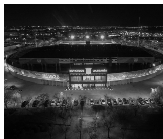
Figura 197. Fachada con lonas.
