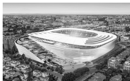
Figura 21. Estadio tras las obras pendientes por ejecutar.
