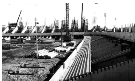
Figura 94. Construcción del graderío.
