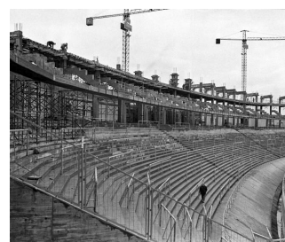
Figura 113. Reforma de la grada Norte.
