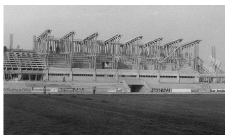
Figura 48. Construcción primera cubierta.
