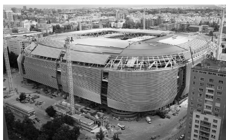
Figura 209. Obras para cubrir la fachada.
