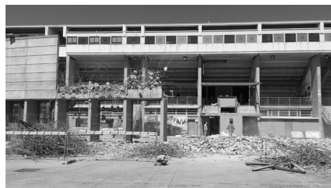
Figura 196. Derribo de la fachada.
