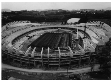
Figura 238. Construcción del estadio.
