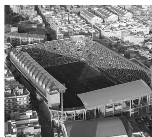
Figura 161. Estadio previo obras Fondo Norte.
