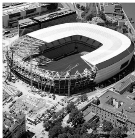
Figura 219. Construcción del estadio.
