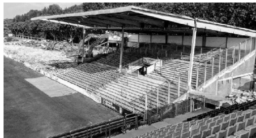
Figura 107. Demolición de la grada Lateral original.
