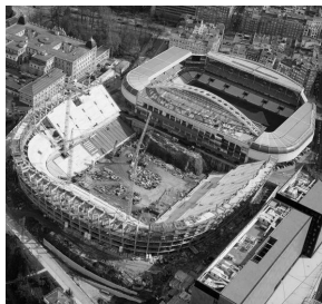
Figura 218. Construcción del estadio.
