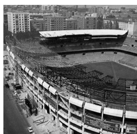
Figura 205. Obras cubierta para el Mundial.
