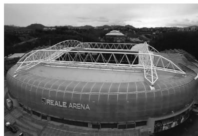
Figura 243. Fachada revestida con paneles de ETFE.
