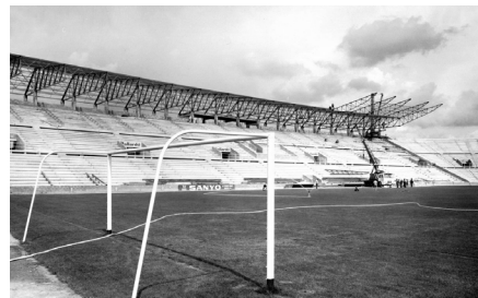
Figura 146. Construcción de la cubierta original.
