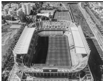
Figura 38. Estadio tras renovaciones del 2012.
