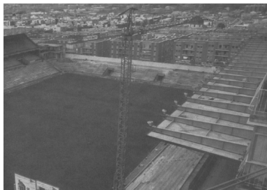
Figura 198. Construcción del estadio.
