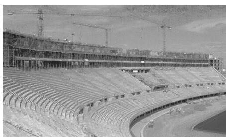
Figura 81. Construcción de la cubierta.
