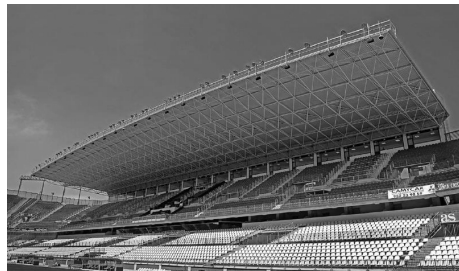
Figura 39. Estructura de la cubierta.
