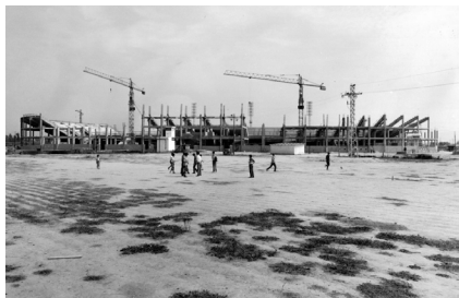
Figura 145. Construcción del estadio.
