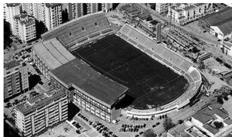
Figura 23. Estadio antes de la reforma de 2001.
