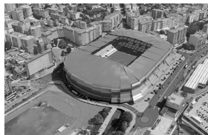
Figura 171. Aspecto final del estadio tras las obras.
