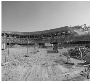
Figura 122. Derribo del tercer graderío.
