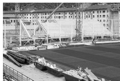
Figura 236. Obras en la tribuna Oeste.
