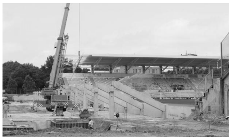
Figura 108. Construcción nueva grada Lateral.
