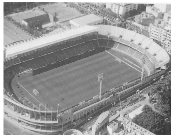
Figura 90. Inicio obras en la grada San Sebastián.
