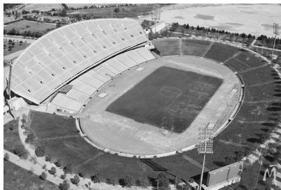
Figura 179. Grada "La Peineta" en el Estadio de Madrid.
