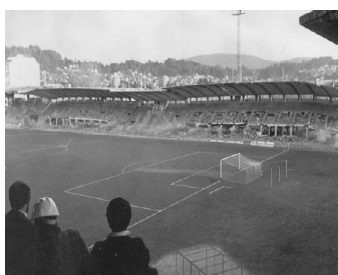
Figura 165. Demolición antigua Grada Río.
