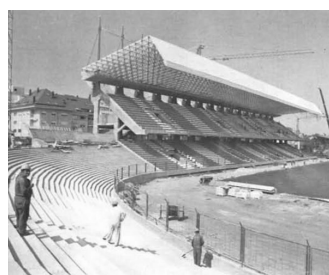
Figura 173. Obras Grada Tribuna en 1980.
