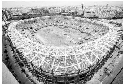
Figura 149. Estructura de la actual cubierta.
