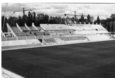
Figura 211. Construcción del estadio.
