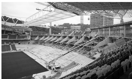
Figura 241. Obras en el fondo Norte.
