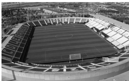
Figura 195. Vista aérea con las gradas ampliadas.
