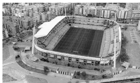
Figura 32. Vista aérea con las esquinas cerradas.
