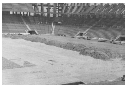
Figura 138. Construcción del estadio.
