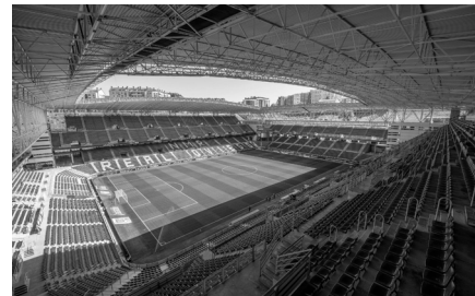
Figura 66. Interior del estadio.
