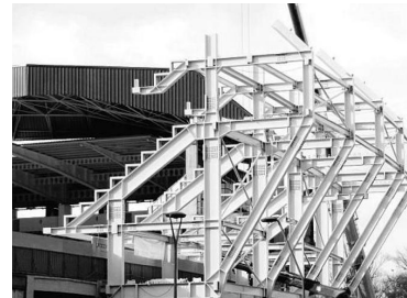
Figura 70. Ampliación con estructura metálica.
