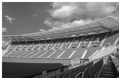
Figura 77. Tribuna Este finalizada tras las obras.
