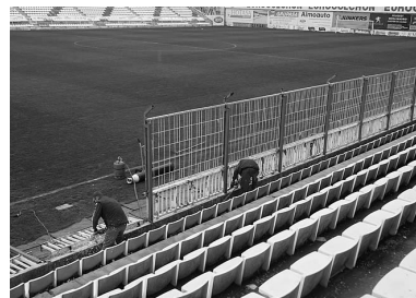
Figura 202. Eliminación de las vallas de seguridad.
