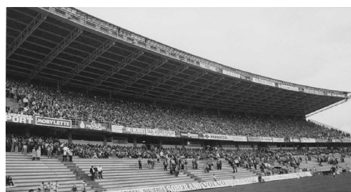
Figura 112. Estructura de la cubierta.
