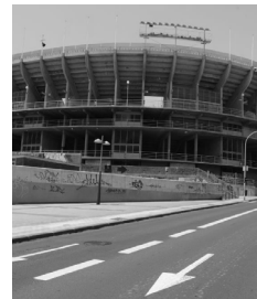
Figura 91. Exterior del estadio.
