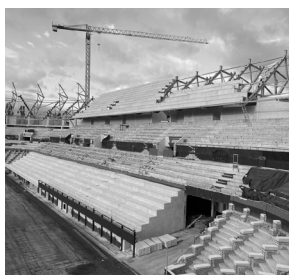
Figura 214. Estructura del nuevo graderío.
