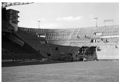
Figura 152. Derribo de las gradas con estructura de ladrillo.
