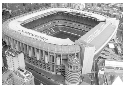
Figura 208. Estadio previo a las últimas reformas.
