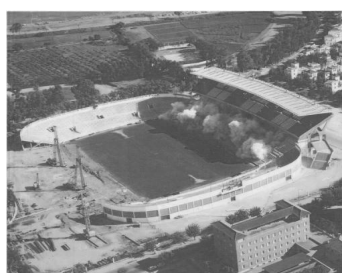
Figura 17. Demolición tribuna Preferencia.
