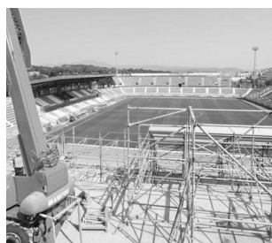
Figura 134. Colocación gradas supletorias.
