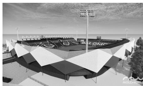
Figura 104. Estadio final tras la reforma de la fachada.
