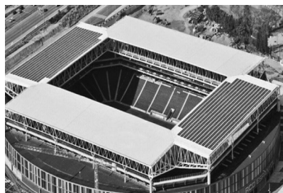
Figura 129. Cubierta tras la colocación de placas solares.
