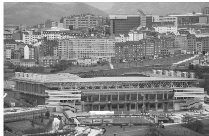
Figura 65. Exterior del estadio.
