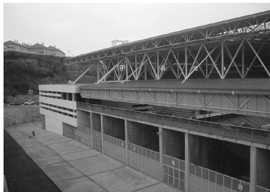
Figura 64. Aspecto exterior + estructura de la cubierta.
