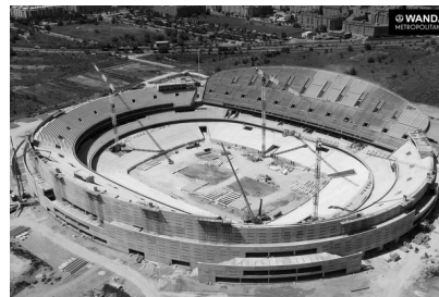
Figura 181. Construcción del graderío.
