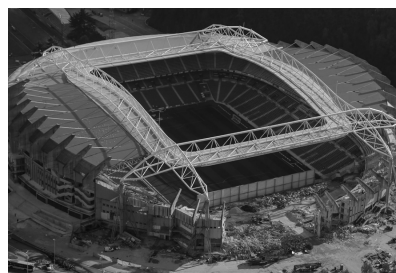
Figura 240. Derribo del fondo Norte.
