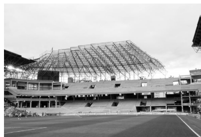
Figura 170. Estructura de la cubierta de la Grada Marcador.
