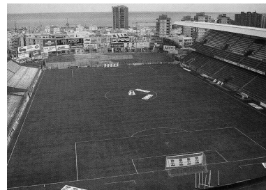
Figura 88. Obras de la grada Gol.
