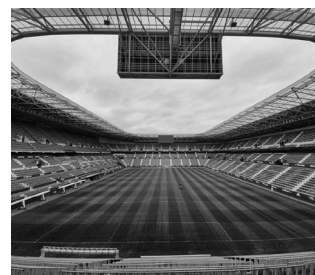
Figura 216. Vista interior actual del estadio.
