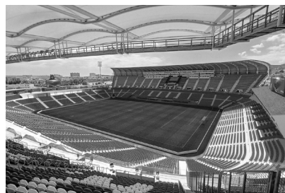
Figura 79. Interior del estadio tras las obras.
