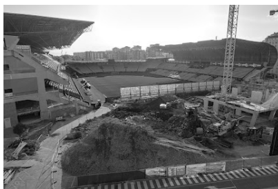
Figura 169. Inicio de las obras en el fondo.
