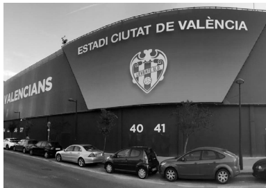
Figura 148. Fachada cubierta mediante lonas.
