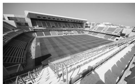
Figura 27. Interior del actual estadio.
