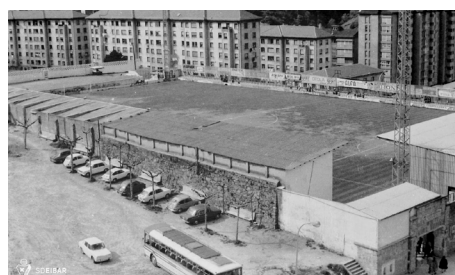
Figura 233. Estadio tras la construcción de nuevas cubiertas.
