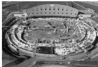
Figura 180. Obras sobre el terreno.
