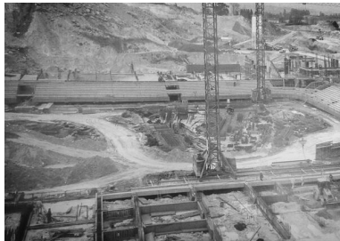
Figura 61. Construcción del estadio.
