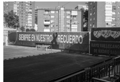
Figura 200. Muro del fondo Este.
