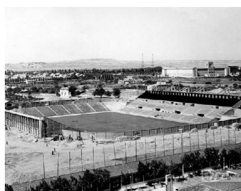
Figura 55. Estructura del graderío.
