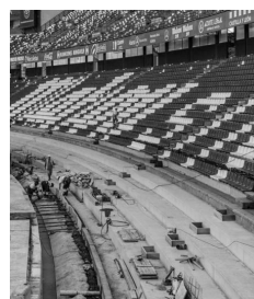
Figura 115. Obras en el foso.
