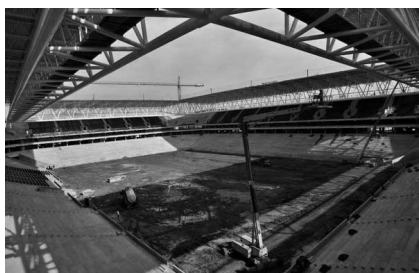
Figura 125. Construcción del estadio.
