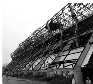
Figura 167. Estructura placas de la fachada.
