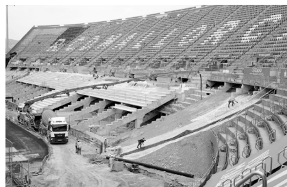
Figura 78. Obras en el Fondo Norte.
