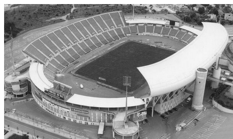
Figura 75. Vista aérea del estadio original.
