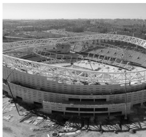
Figura 182. Estructura de la cubierta.
