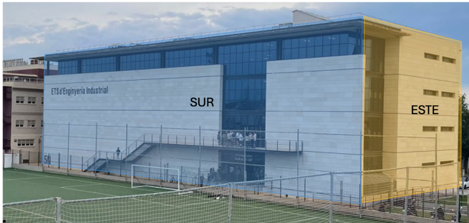
Figura 4. Edificio 5N. Fachadas este y sur.
