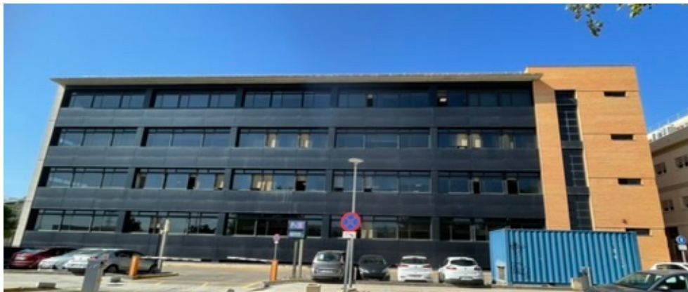
Figura 5. Edificio 5N. Fachada norte.
