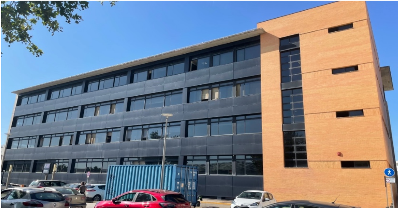
Figura 29. Vista de la fachada norte del edificio 5N.
