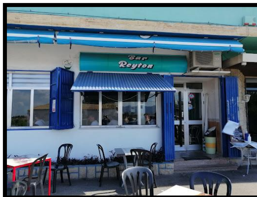
ILUSTRACIÓN 7: FACHADA BAR REYTON
