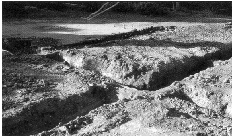
Figura 32: Construcción de los cimientos originales mediante bóvedas tabicadas (1928)
