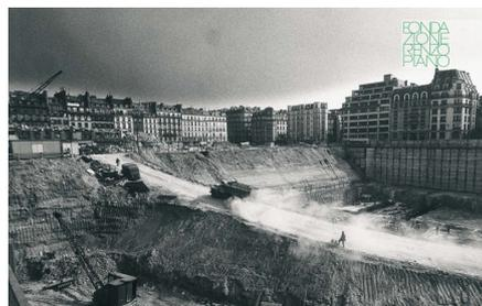
Fig. #. Primeras etapas de construcción: excavación de 16.000 m<sup>2</sup>. 1973.
