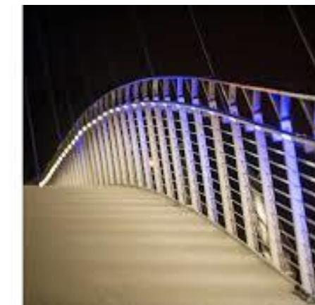
Figura 17: Iluminación tipo en el tablero de la pasarela
