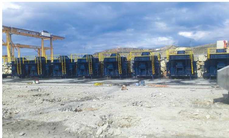
Figura 48 Línea de encofrado en serie. Fuente: Web del Cubípod.
