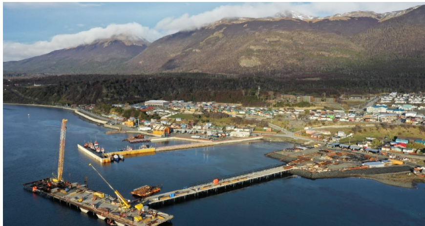
Figura N° 1: Vista aérea Muelle Multipropósito Etapa 1 en Ejecución. Fuente: Propia.
