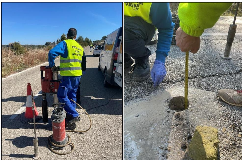
FIGURA 19. CAMPAÑA DE EXTRACCIÓN DE TESTIGOS. FUENTE: ELABORACIÓN PROPIA.
