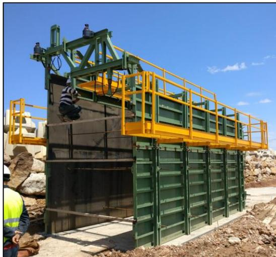
*Imagen 9. Encofrado del espaldón (Fuente: rubricaingenieria.com)*
