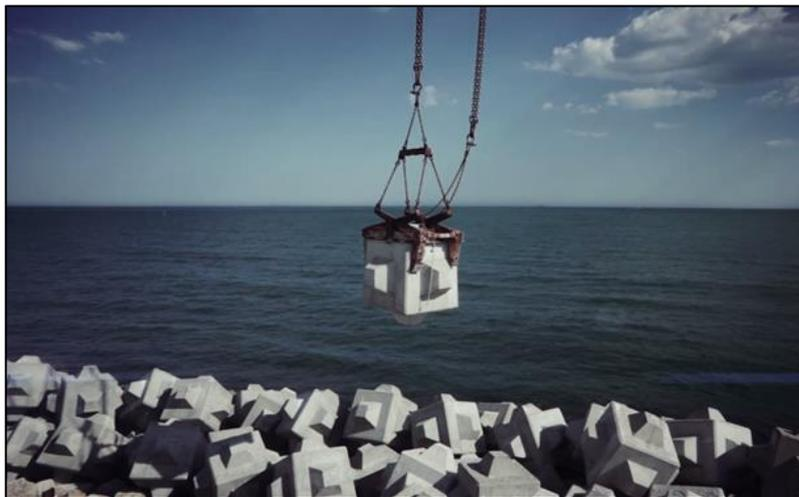
*Imagen 8. Colocación de cubípodos mediante pinzas de presión doble (Fuente:cubipod.com)*
