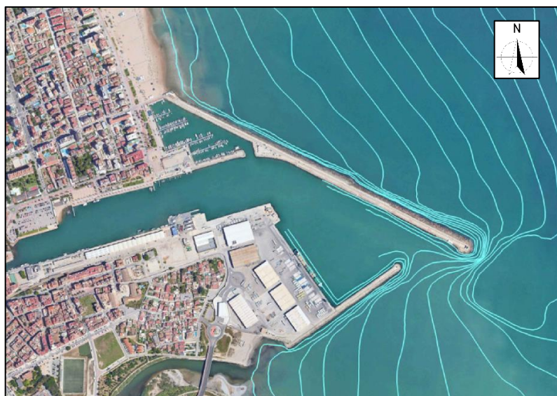
Imagen 3. Batimetría actual del Puerto de Gandía (Fuente: Google Earth).
