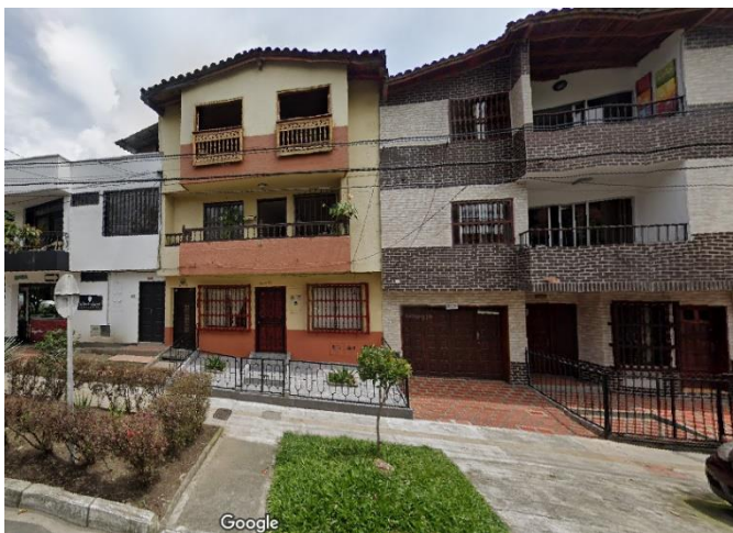
Ilustración 40. Casa en el centro urbano de Envigado
