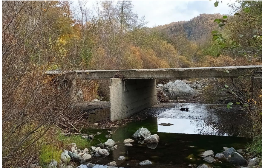
Figura 3. Vista del vado existente desde aguas arriba hacia aguas abajo. Fuente: Politecnico di Torino.
