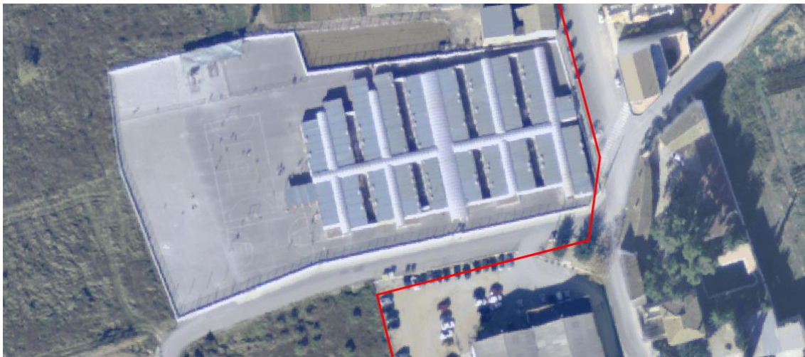
Figura 34. Ortofoto de la construcción n°6 del año 2010. Fuente: ICV
