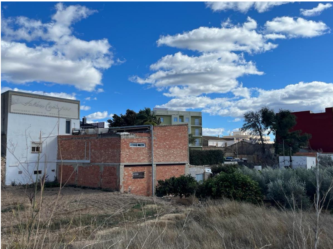
Figura 4. Parte trasera de la edificación residencial nº2. Fuente: Elaboración propia.
