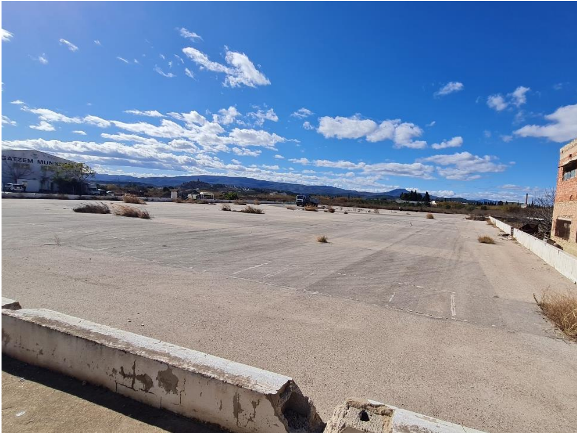
Figura 13. Estado actual de la explanada (construcción nº6). Fuente: Elaboración propia.
