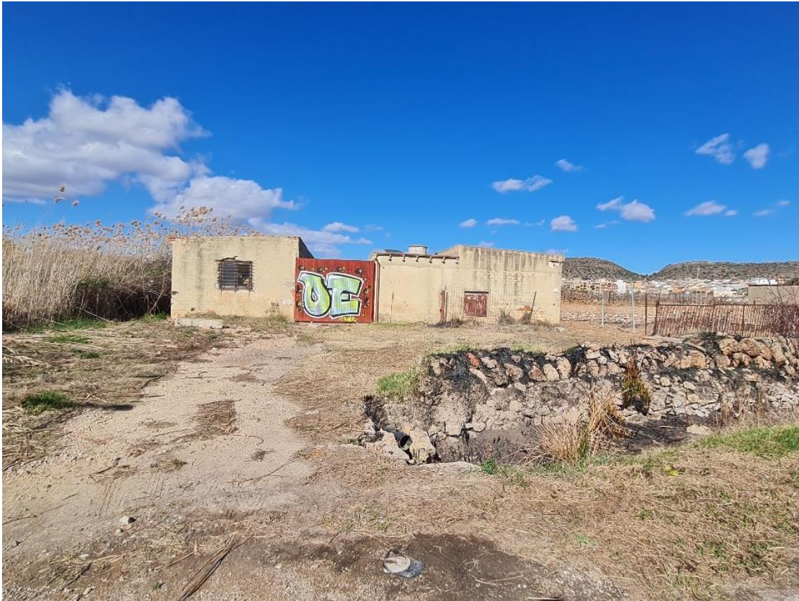
Figura 15. Imagen de la edificación nº7. Fuente: Elaboración propia.
