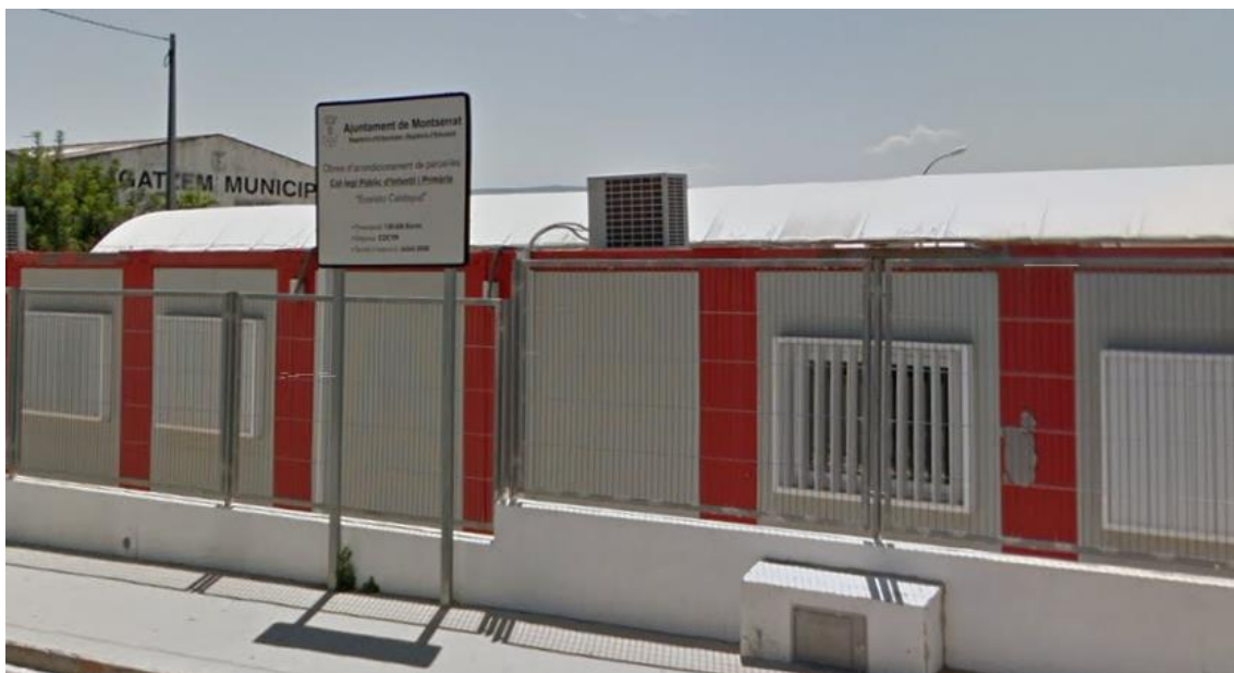
Figura 33. Exterior de a construcción nº6 del año 2010. Fuente: Google Earth
