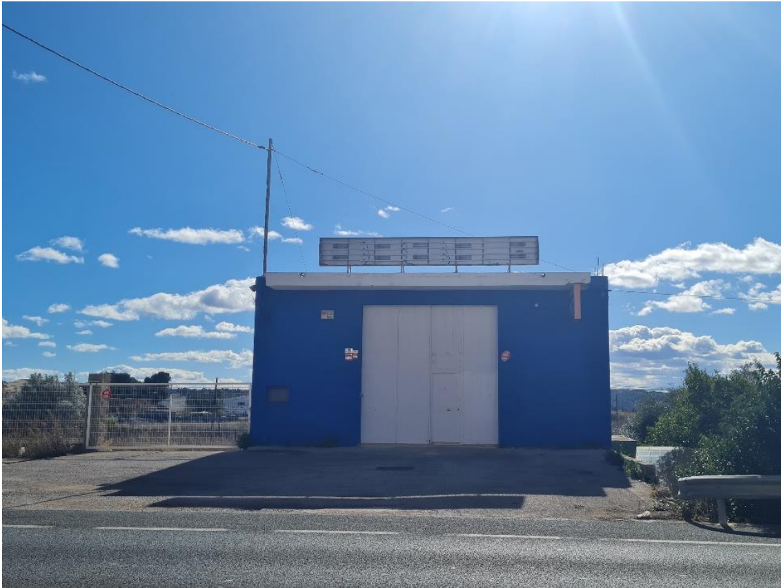
Figura 1. Exterior de la edificación nº1. Fuente: Elaboración propia.
