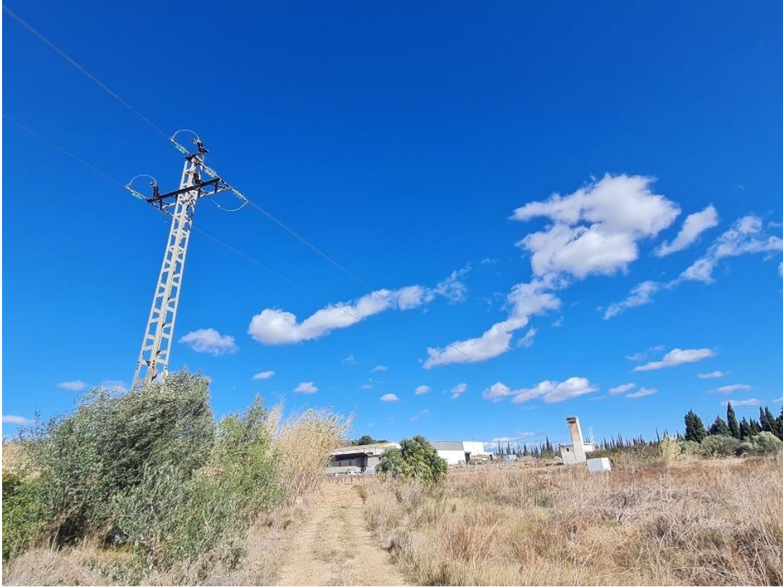
Figura 19. Apoyo metálico en el interior del sector. Fuente: Elaboración propia.
