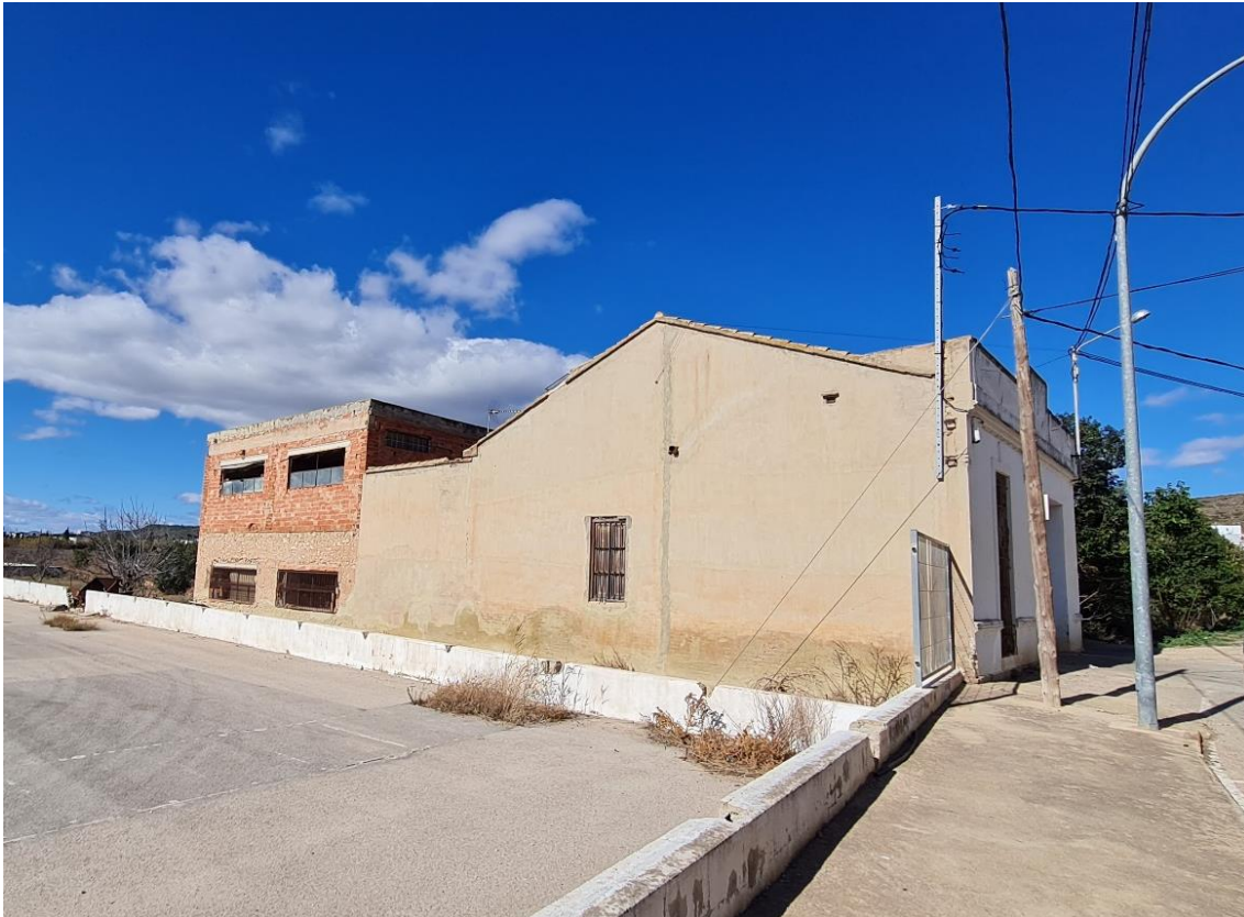
Figura 11. Lateral de la construcción nº6. Fuente: Elaboración propia.
