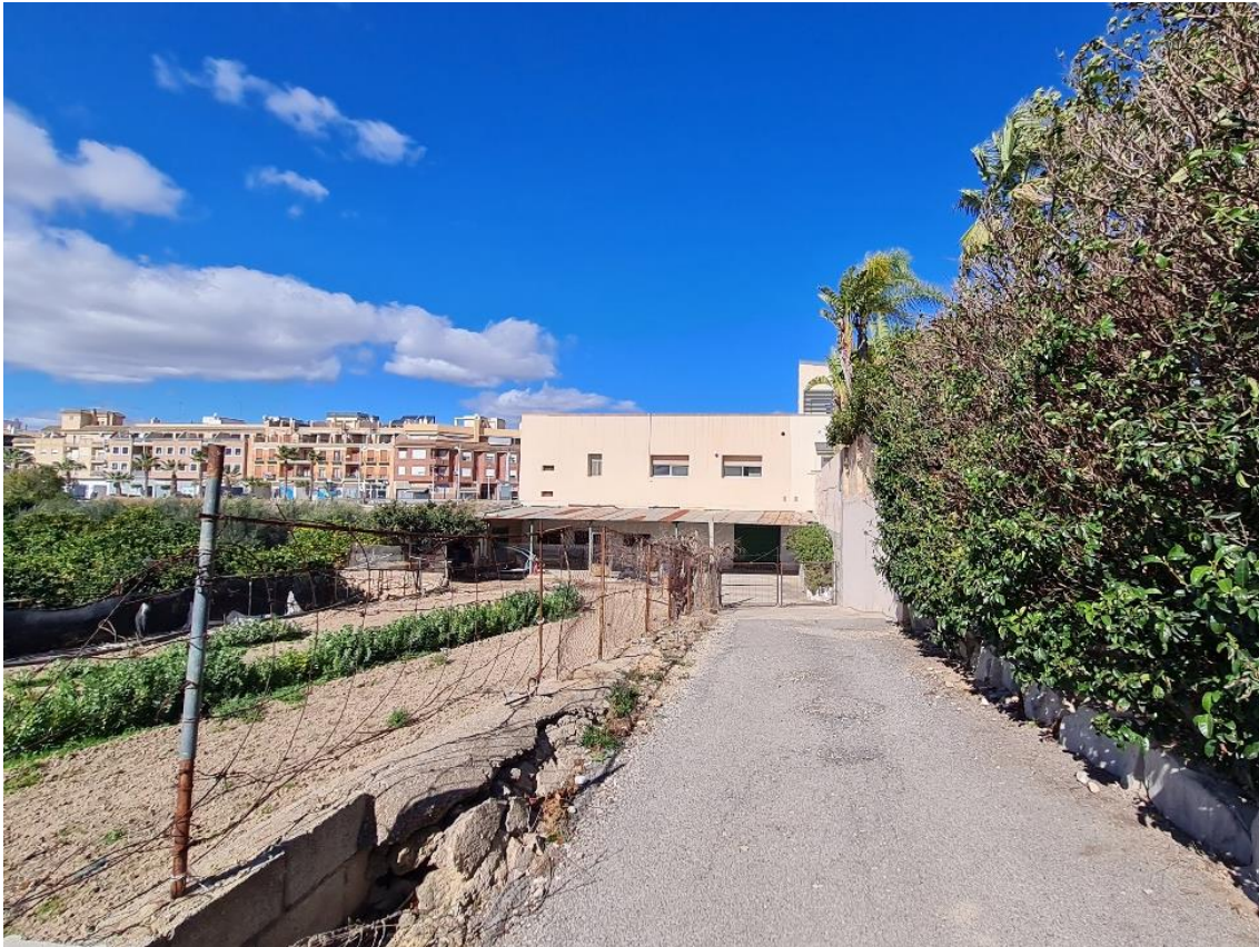
Figura 5. Parte delantera de la edificación residencial nº2. Fuente: Elaboración propia.
