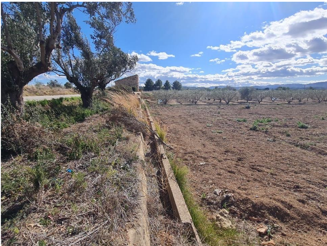
Figura 18. Estado actual de una acequia del sector. Fuente: Elaboración propia.
