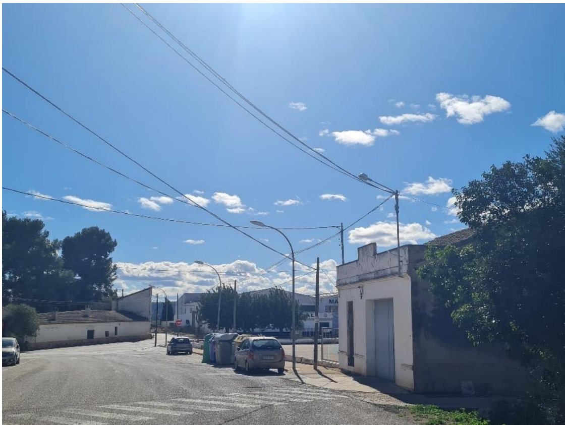
Figura 22. Iluminación en las inmediaciones de la edificación nº6. Fuente: Elaboración propia.
