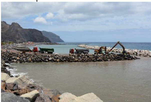
Figura 35, construcción de dique exento mediante camino rodado (fuente: El País)
