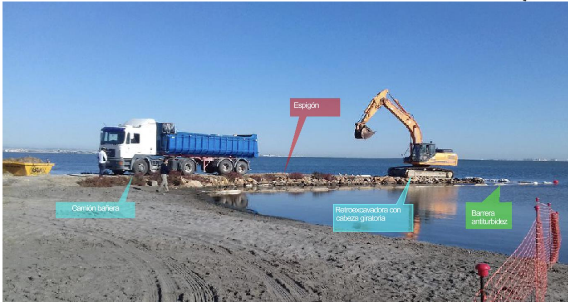
Figura 96, transporte de la escollera removida (fuente: Proyecto de retirada del espigón de Punta Brava).
