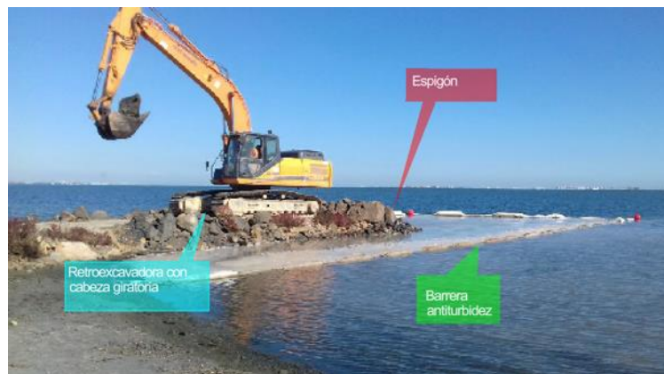
Figura 95, extracción de la escollera por parte de la retroexcavadora (fuente: Proyecto de retirada del espigón de Punta Brava).
