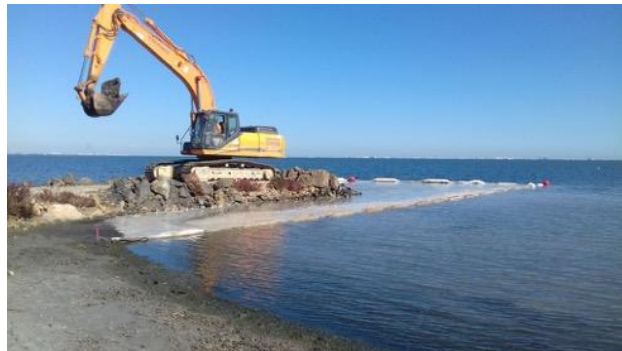
Figura 33, retirada de la estructura de defensa.
