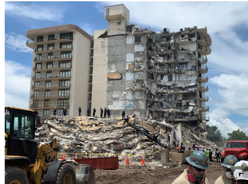
Figura 15. Colapso del Champlain Towers South [28].
