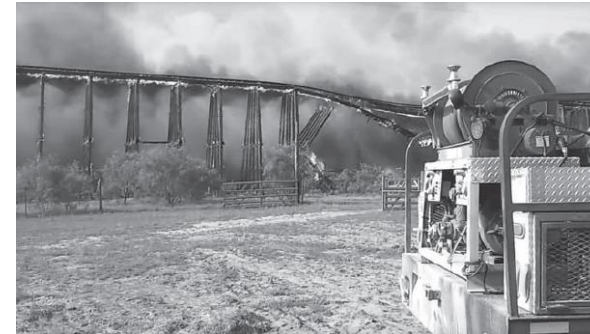
Imagen 7. Ejemplo de un puente donde el fuego desencadenó un colapso tipo dominó [6].
