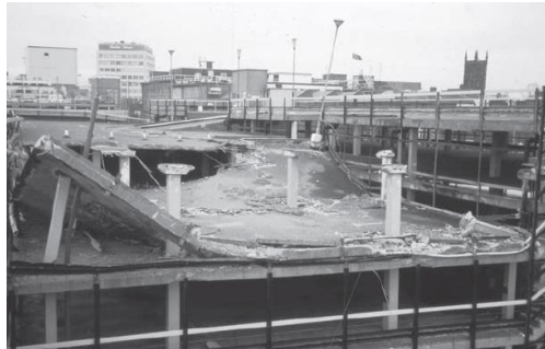
Imagen 6. Ejemplo de colapso tipo cremallera [6].
