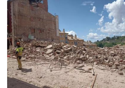
Imagen 4. Escombros después del colapso del edificio de Teruel [4].
