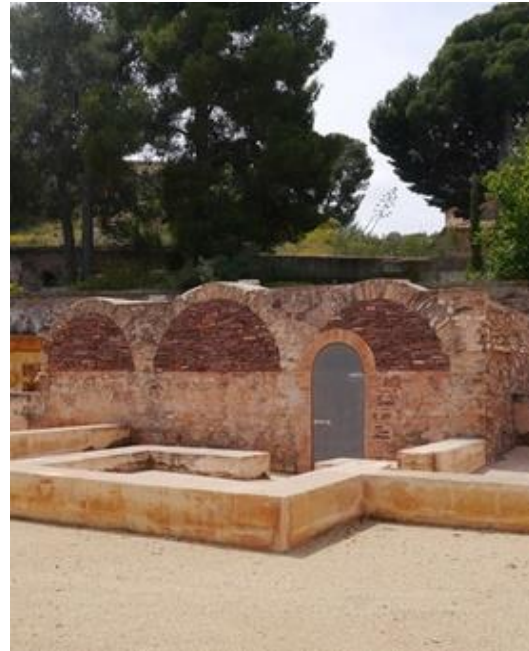
Figura 40. Baños árabes de Torres-Torres (Fuente: Google Imágenes).
