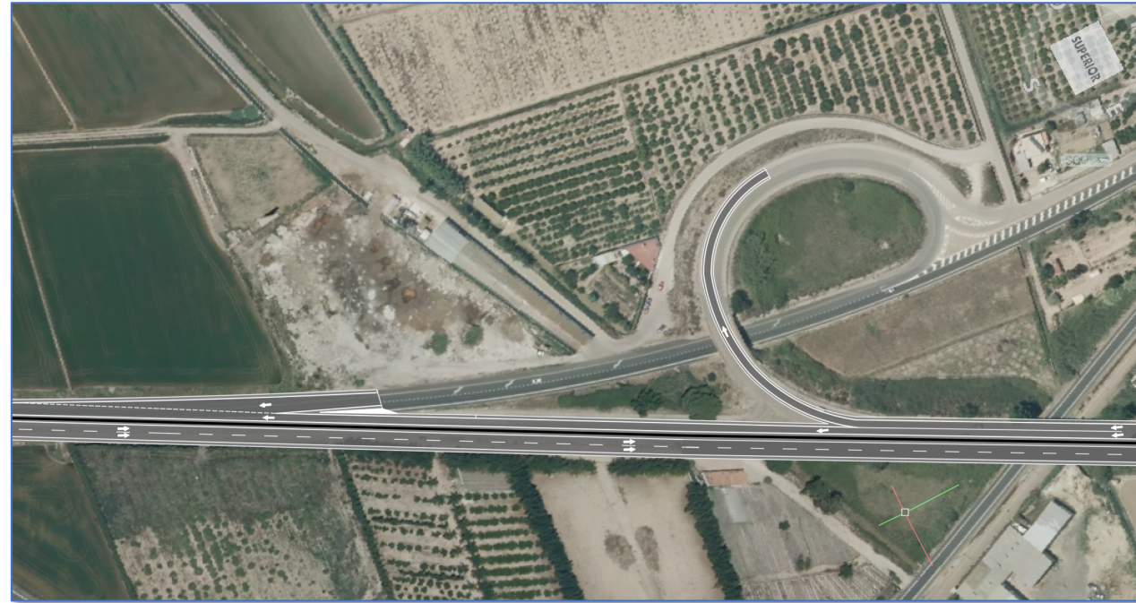
Figura 4 - Enlace CV-5040 con N-332 en sentido salida. | Fuente: Elaboración propia
