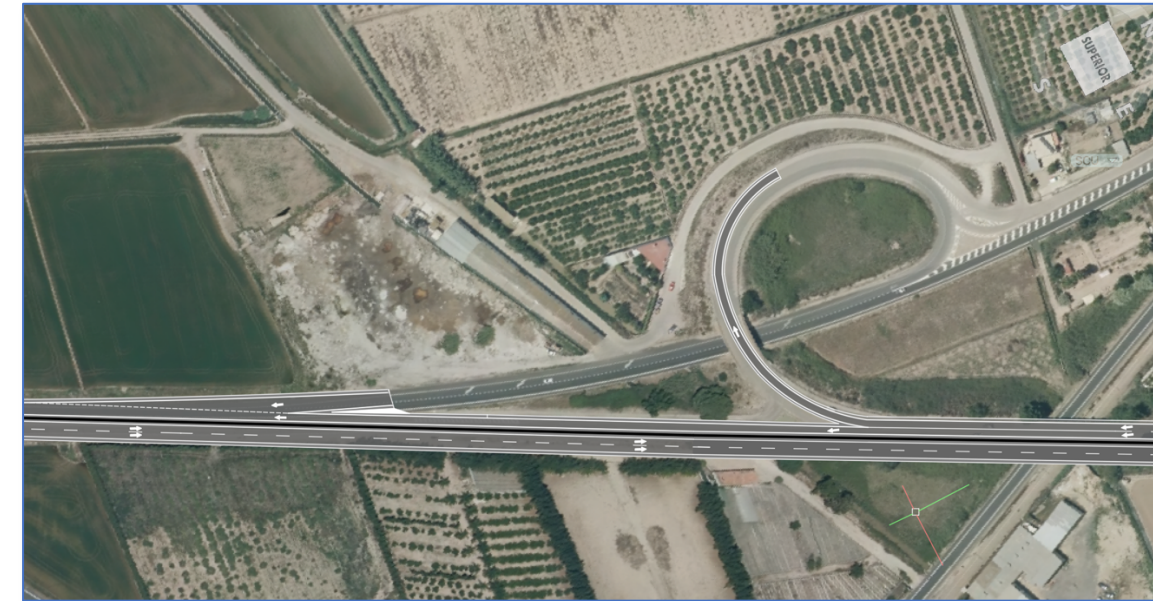
Figura 7-Enlace CV-5040 con N-332 en sentido salida. | Fuente: Elaboración propia
