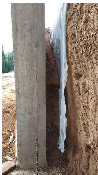
Ilustración 18. Fotografía tomada durante la ejecución de las obras: protección del corte vertical del terreno y relleno del trasdós del muro con material granular. Fuente: propia
