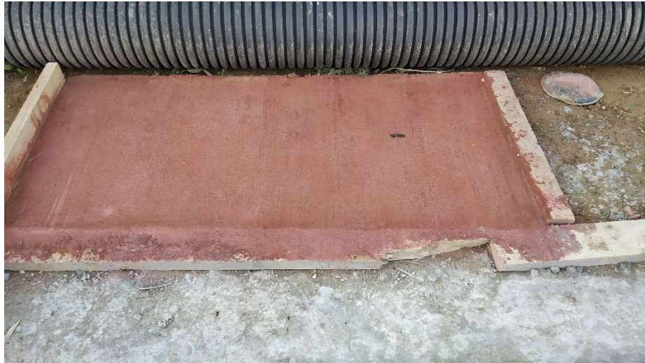
Ilustración 11. Fotografía tomada durante la ejecución de las obras: muestra del acabado coloreado y texturizado. Fuente: propia
