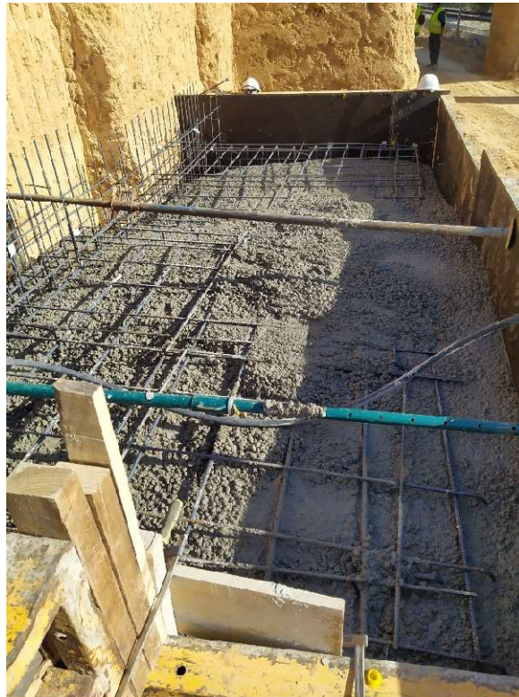
Ilustración 5. Fotografía tomada durante la ejecución de las obras: hormigonado de una zapata, previamente ferrallada. Fuente: propia
