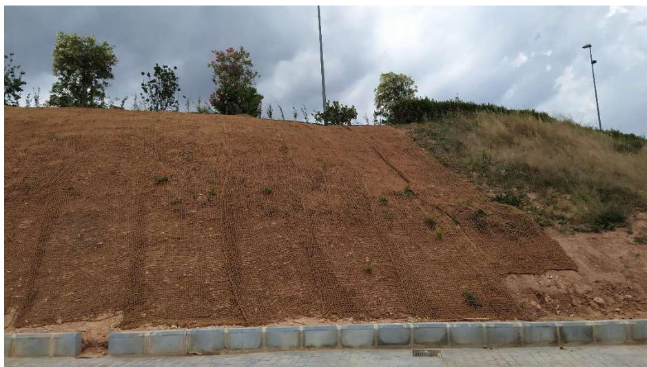
Ilustración 15. Fotografía tomada durante la ejecución de las obras: obra finalizada, protección de talud reperfilado con hidrosiembra. Fuente: propia
