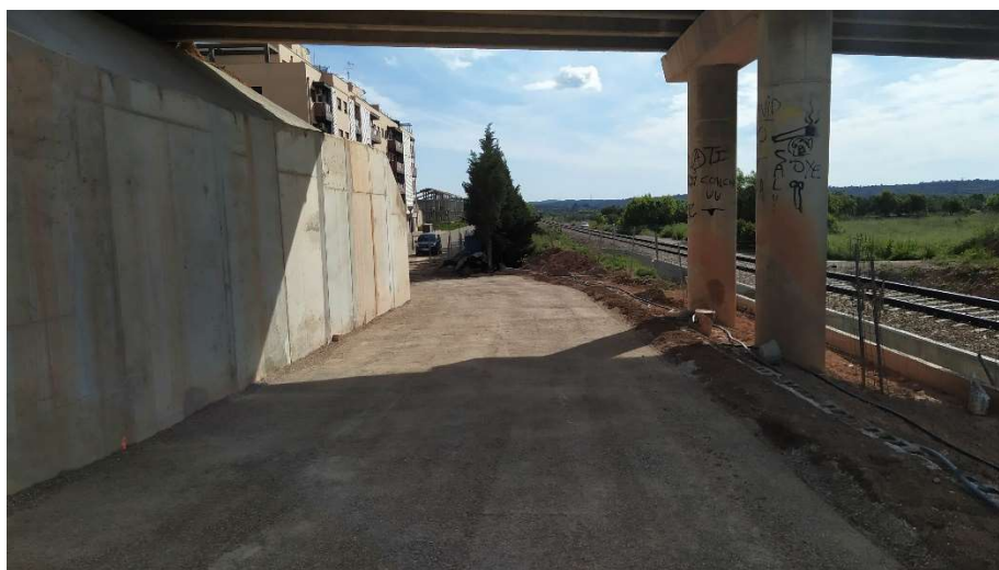
Ilustración 10. Fotografía tomada durante la ejecución de las obras: extendido y compactación de zahorras. Fuente: propia
