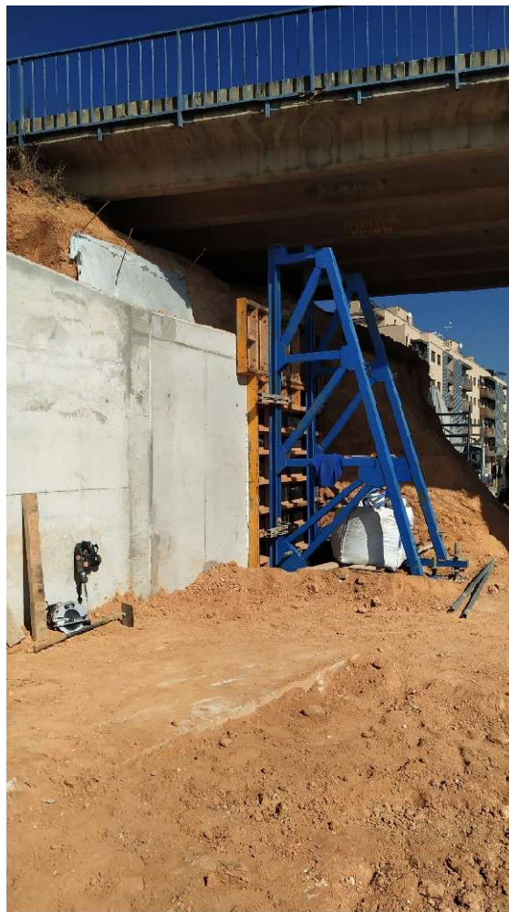
Ilustración 9. Fotografía tomada durante la ejecución de las obras: alzado de muro del batache 5 encofrado. Fuente: propia
