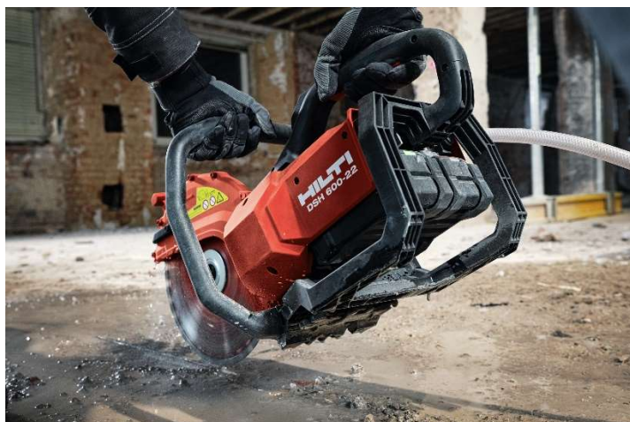
Ilustración 22. Apertura de ventanas en el tablero del puente con sierra de corte de hormigón armado. Fuente: HILTI ESPAÑA ( https://www.hilti.es )
