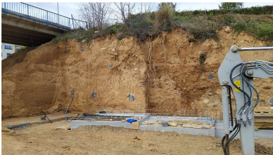
Ilustración 16. Fotografía tomada durante la ejecución de las obras: excavación simultánea de varios bataches al mismo tiempo en los laterales. Fuente: propia
