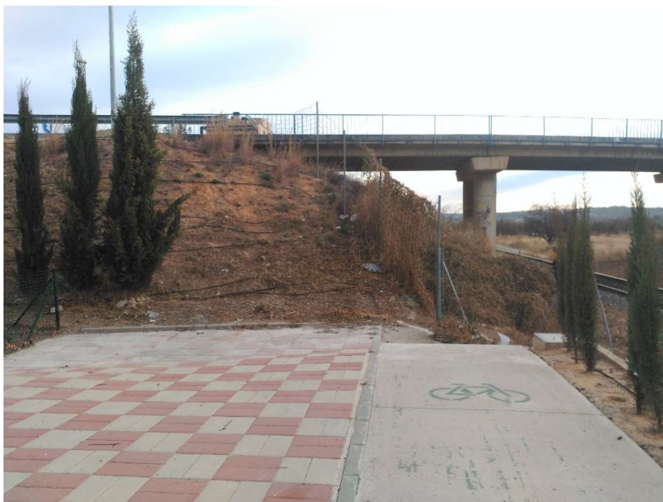
Ilustración 2. Fotografía tomada durante las obras: talud existente a rebajar, se aprecian algunas vallas a retirar y arbolado a proteger. Fuente: propia
