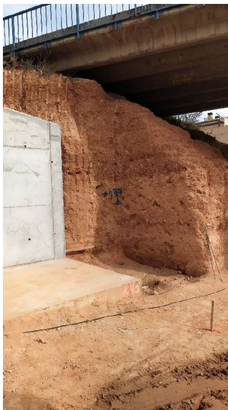
Ilustración 8. Fotografía tomada durante la ejecución de las obras: excavación del batache 4. Fuente: propia
