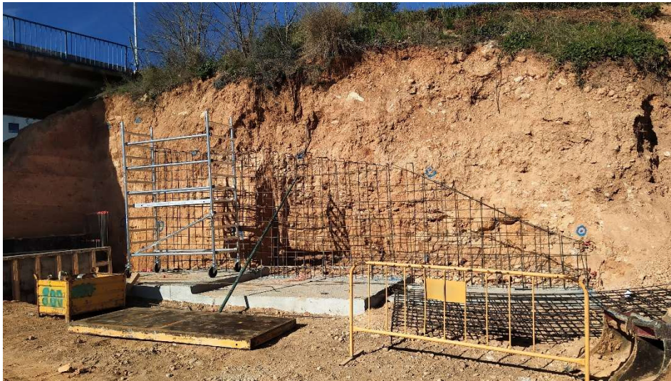
Ilustración 6. Fotografía tomada durante la ejecución de las obras: ferrallado de alzado de muro.
