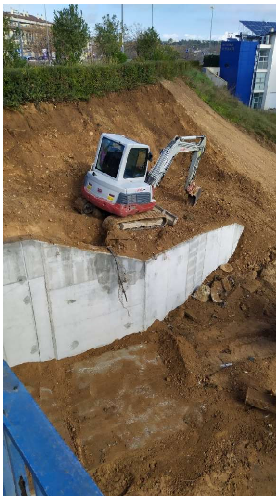
Ilustración 19. Fotografía tomada durante la ejecución de las obras: miniexcavadora realizando rebaje del talud, una vez finalizada la ejecución del muro. Fuente: propia
