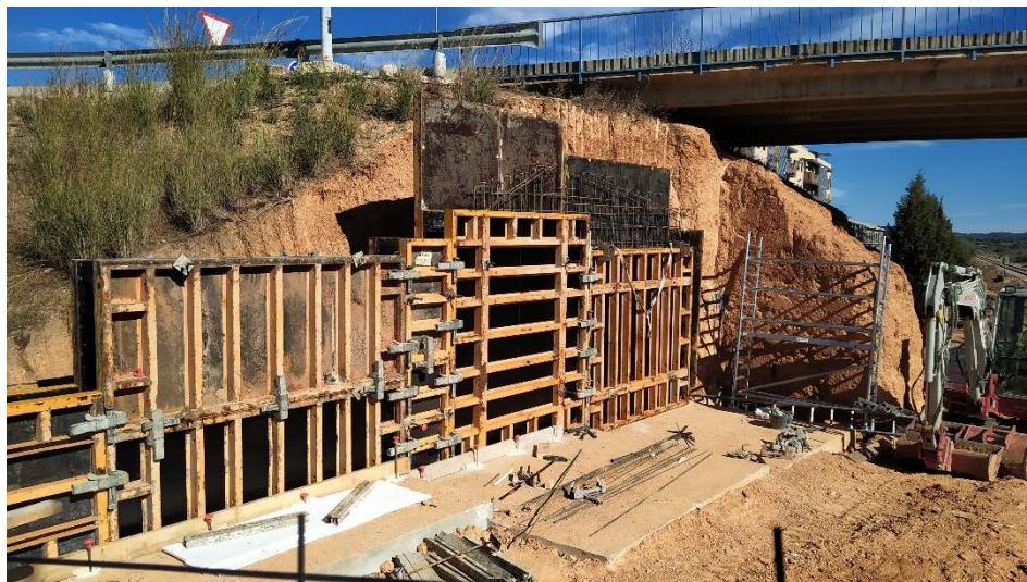
Ilustración 7. Fotografía tomada durante la ejecución de las obras: encofrado de alzado de muro.
