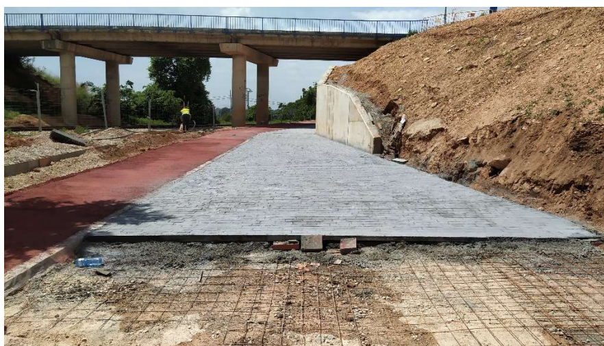
Ilustración 12. Fotografía tomada durante la ejecución de las obras: extendido de hormigón en zona peatonal. Fuente: propia
