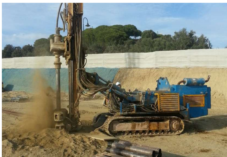
Ilustración 25. Micropilotadora realizando perforación. Fuente: PILOTECH LEVANTE ( https://www.pilotechlevante.com )
