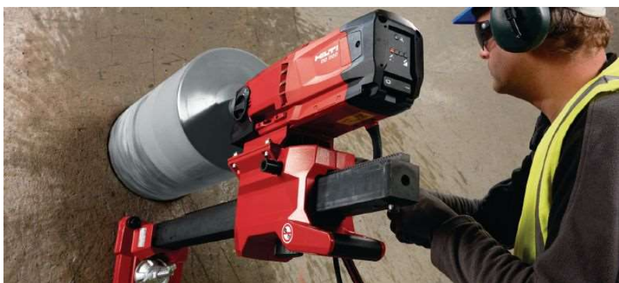
Ilustración 23. Perforación del estribo con corona de corte de hormigón armado. Fuente: HILTI ESPAÑA ( https://www.hilti.es )
