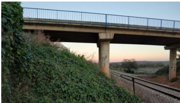
Ilustraciones 5 y 6. Talud que sustenta la cimentación de la estructura de la CV-378. Fuente: propia
