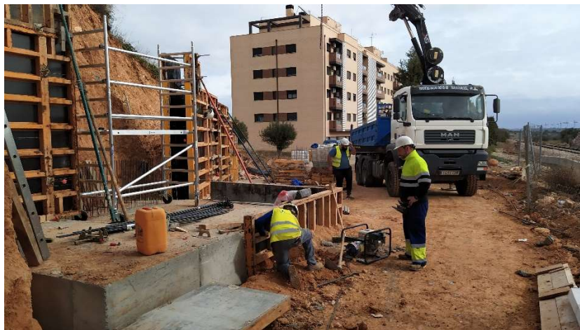
Ilustración 17. Fotografía tomada durante la ejecución de las obras: encofrado a dos caras de algunos bataches de muro laterales. Fuente: propia
