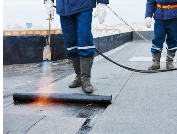
Fig 2.9: Ejecución de impermeabilización mediante lámina asfáltica.
