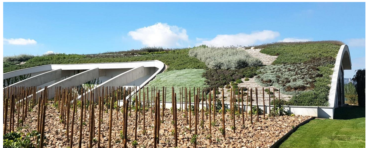
Fig 2.4: Cubierta ajardinada inclinada. Bodegas Ramón Bilbao, La Rioja.
