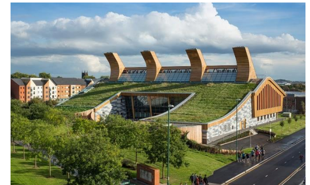
Fig 2.50: Cubierta ajardinada del Centre for Sustainable Chemistry de la universidad de Nottingham, UK.
