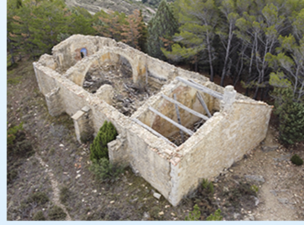
Vista aerea Ermita Santa Bárbara
