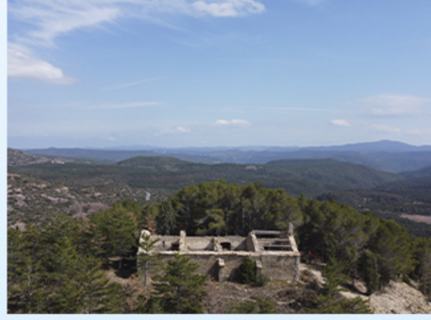
Vista aerea Ermita Santa Bárbara
