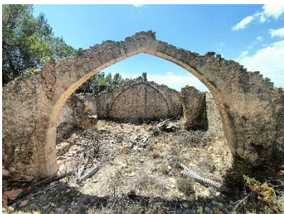
Figura 44. Arco gótico Ermita Santa Bárbara, 2024. Elaboración propia.
